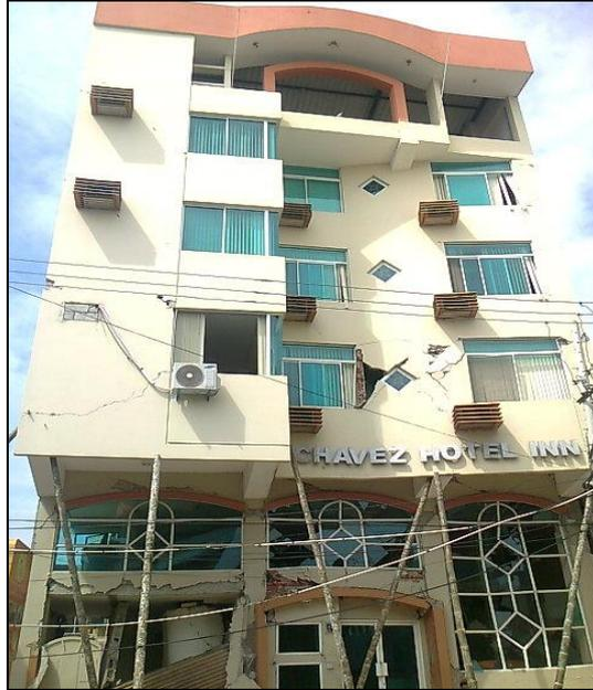
*Ilustración 19. Hotel Chávez Inn ubicado en la ciudad de Manta, afectado por el terremoto de 7,8 en la escala de Richter.*
