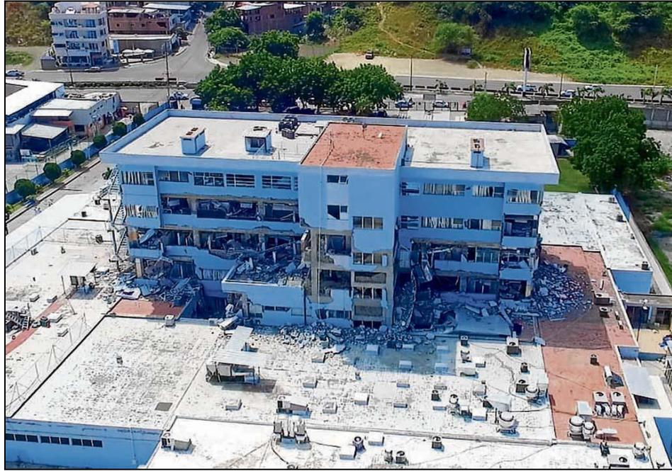
*Ilustración 14. Hospital del IEES de Manta afectado tras el terremoto del 16 de Abril.*
