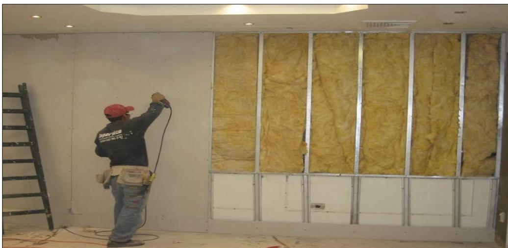
**Figura 30: Instalación de pared gypsum**
