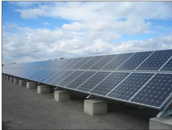
Figura 3.2 Estructura fija módulos solares
