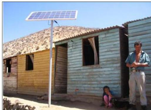
Figura 3.5 Sistema Fotovoltaico Autónomo
