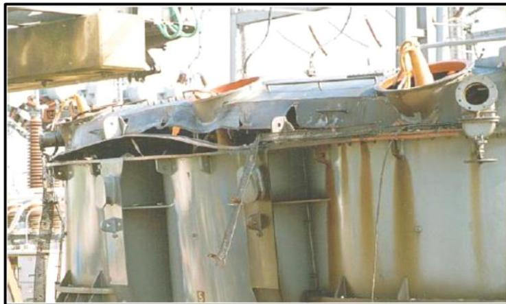
Figura 2.8 Consecuencias tras una falla interna en un Transformador.
