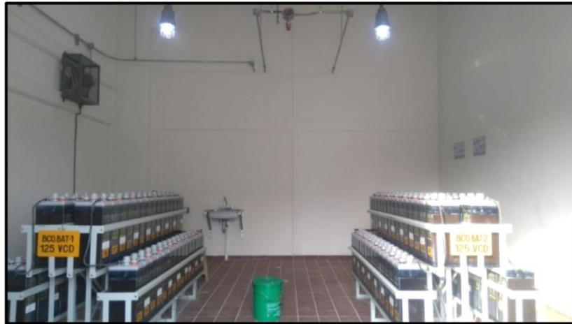
Figura 2.6 Instalación de un sistema contra incendio en el cuarto de baterías.
