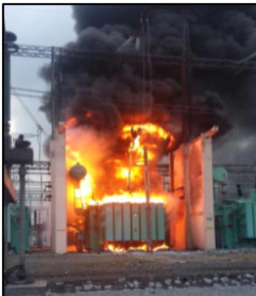
Figura 2.7 Incendio en un transformador de potencia por una explosión
