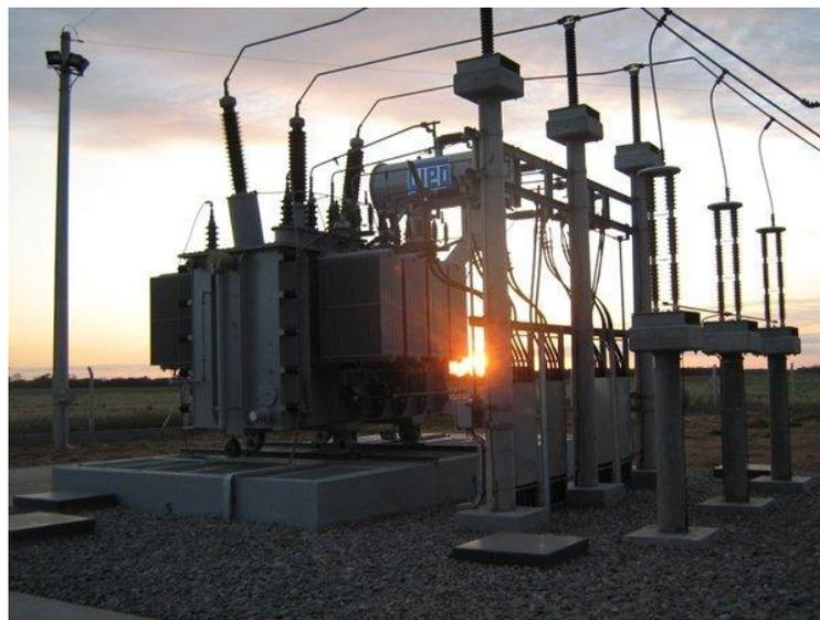
Figura 2.1. Transformador de Potencia 69/13.8kV
