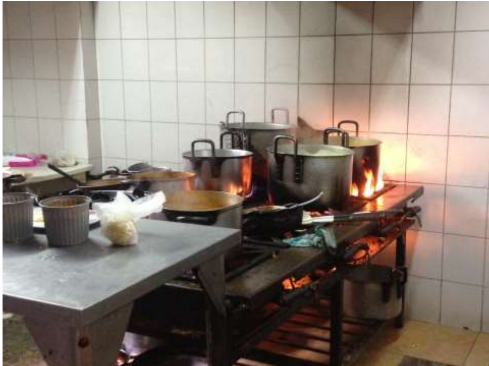
Figura 26 Instalaciones Internas cocina
