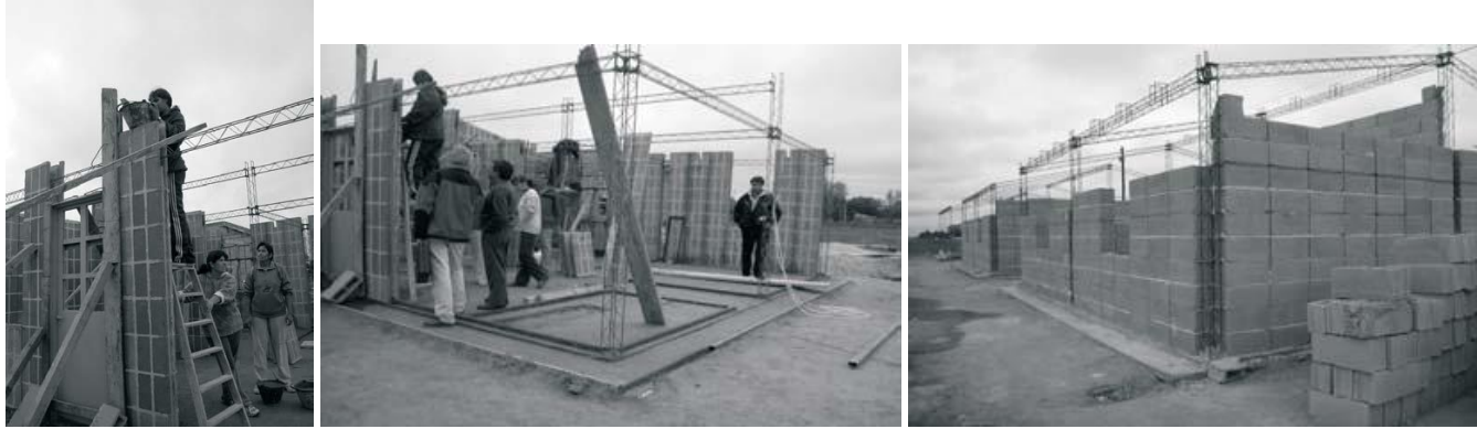
Construcción viviendas MIDUVI
