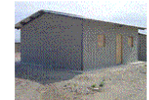
Estructura Metálica y Concreto
