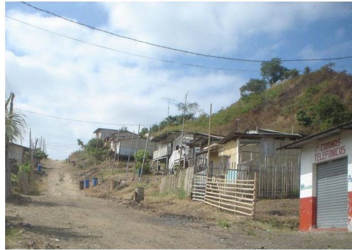
VIVIENDAS DE MADERA, CAÑA Y BLOQUES-COMERCIO CON CUBIERTAS METALICAS. MONTE SINAI.
