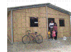
Estructura Metálica y Caña
