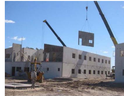
Detalle unión entre paneles montaje de paneles
