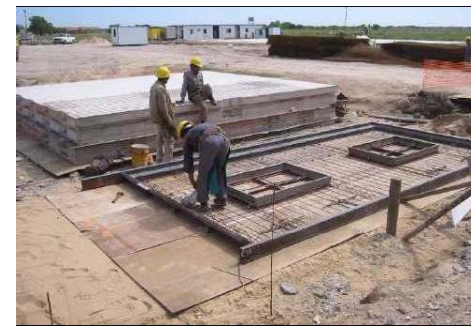
Hormigón prefabricado con uniones húmedas
