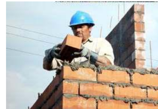
Cerramientos verticales, muros de ladrillos
