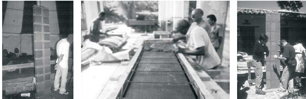
Construcción viviendas MIDUVI
