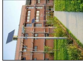
desde la batería para el encendido automático de la luminaria de alta luminosidad LED. El sistema puede programarse para trabajar horas determinadas durante la noche utilizando un sistema de ahorro energético para minimizar el uso de la batería, optimizando los recursos..
