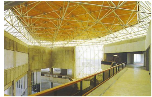
INTERIOR DEL HALL - CUBIERTA DE ESTRUCTURA TRIDIMENSIONAL
