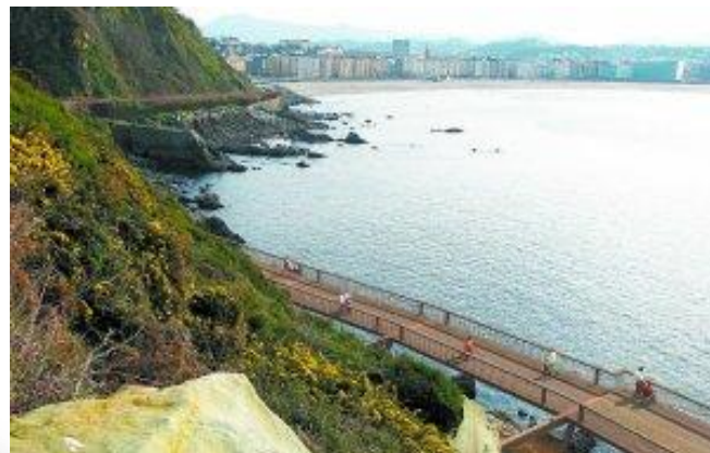
Foto 53. Pasarela Monpás Fuente: Folleto Monpás Ayuntamiento de San Sebastián
