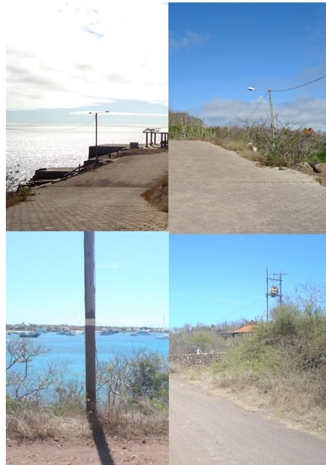
Foto 37, 38, 39 y 40: Infraestructura eléctrica Fuente: Tesista Carolina Morales Robalino
