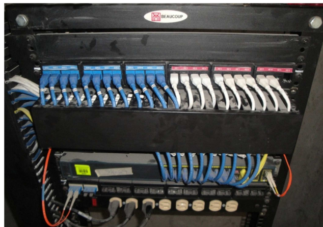
Figura 2.28. Rack del noveno piso.
