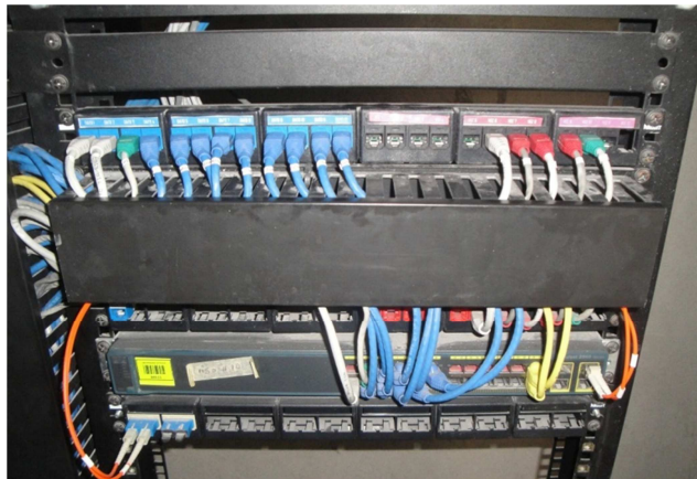
Figura 2.29. Rack del décimo piso. Fuente: [el autor].
