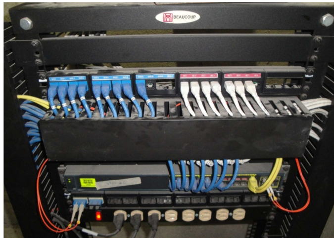
Figura 2.25. Rack del sexto piso. Fuente: [el autor].
