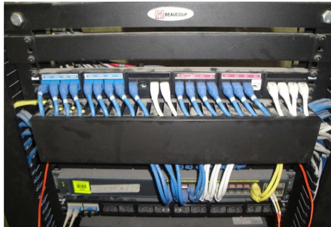
Figura 2.22. Rack del tercer piso. Fuente: [el autor].
