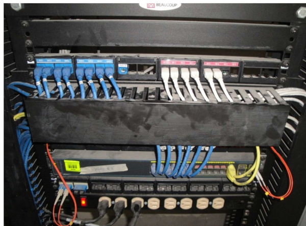
Figura 2.27. Rack del octavo piso.
