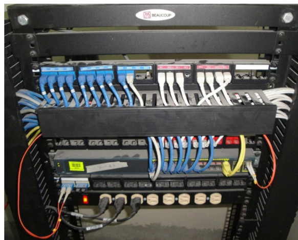
Figura 2.26. Rack del séptimo piso.
