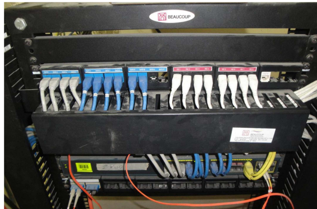
Figura 2.21. Rack del segundo piso. Fuente: [el autor].
