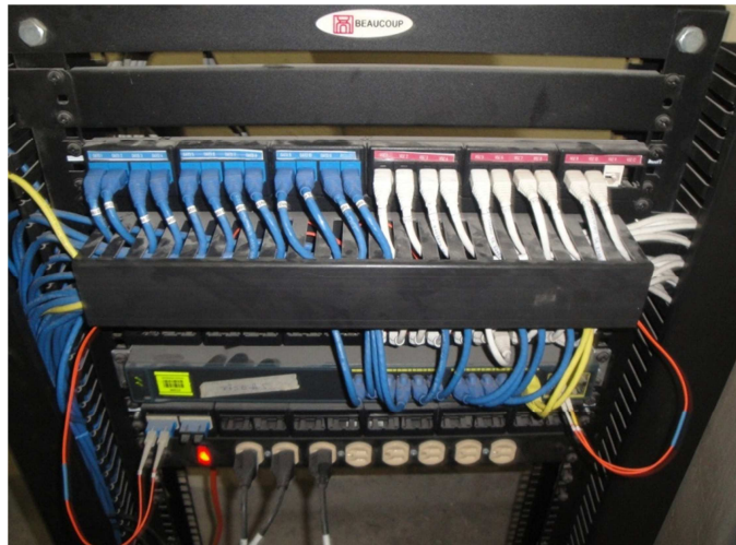
Figura 2.24. Rack del quinto piso.
