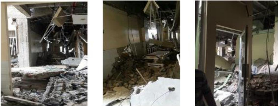
*Ilustración 37: Mampostería y cielo raso colapsado*
