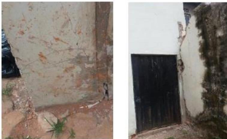
*Ilustración 27: Daños estructurales en Registro de la Propiedad*
