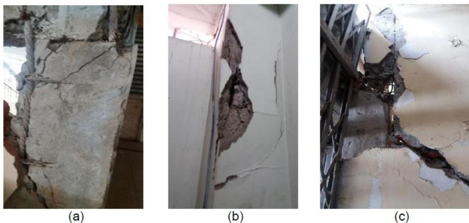
Ilustración 30: a) Falla por corte en nudo de vigas y columnas principales; b) Rotura de columnas principal; c) Fractura de mamposterías.
