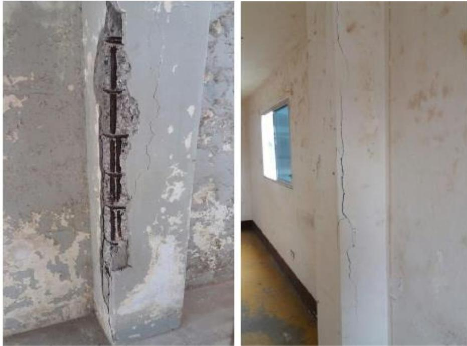
*Ilustración 24: Daños estructurales del Cuerpo de Bomberos*
