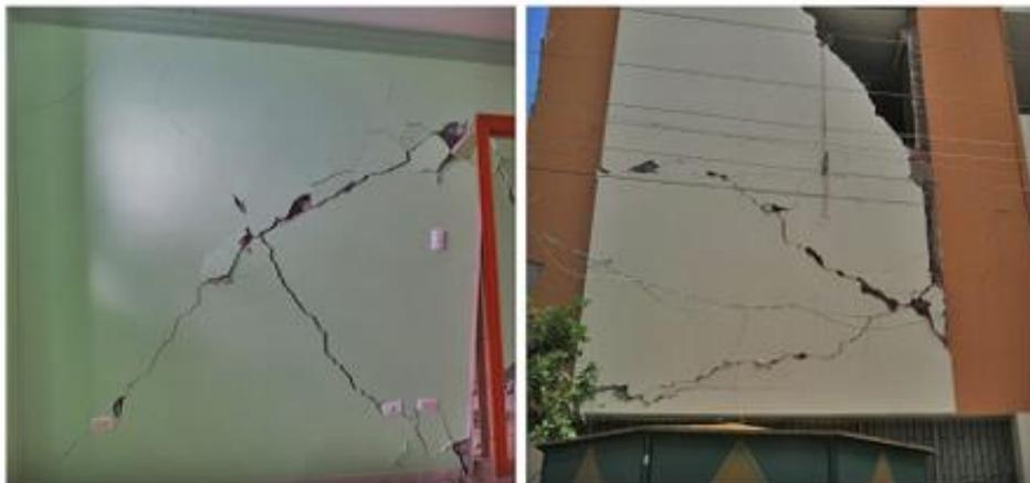
Ilustración 51: Daño Tipo 3
