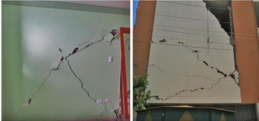
**Ilustración 115 Ejemplo de nivel de daño 3.**
