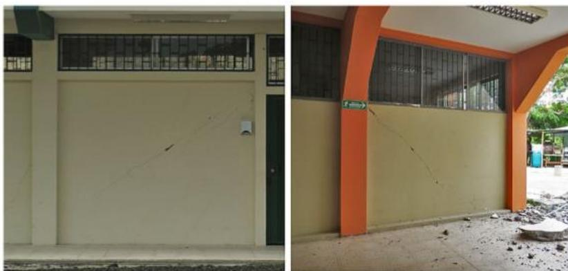
**Ilustración 113 Ejemplo de nivel de daño 1.**
