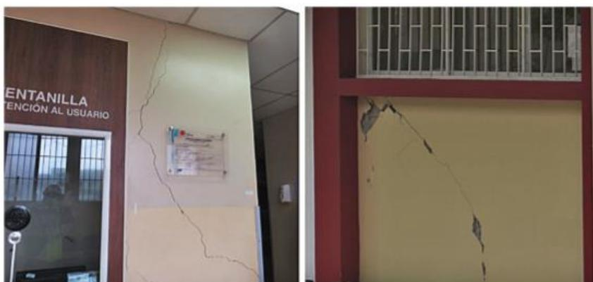
**Ilustración 114 Ejemplo de nivel de daño 2.**
