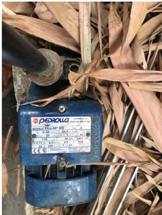
Fotografía 4. Bomba marca "PEDROLLO"- succión de agua residual-Planta Piloto
