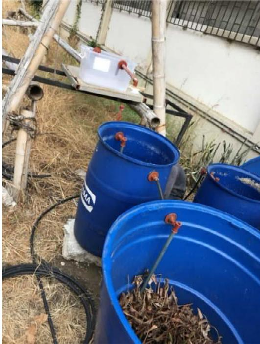
**Fotografía 32. Tanque de Mezcla Rápida, Tanque de Coagulación, Tanque de Floculación y Tanque Clarificador.**
