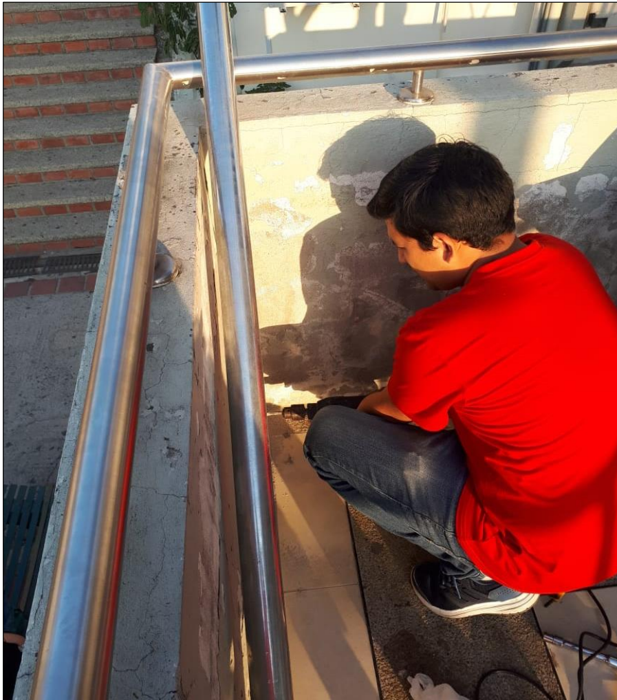
Figura 8. 4 Perforación con taladro para montaje de la luminaria 2 Elaborado por: El autor.
