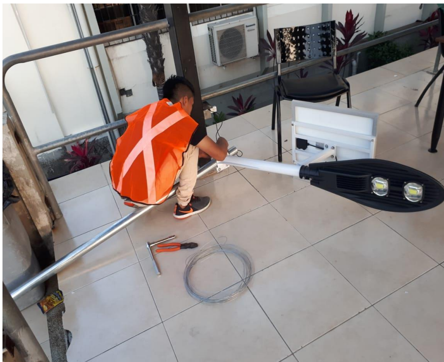
Figura 8. 5 Montaje de los componentes de la luminaria 2 Elaborado por: El autor.
