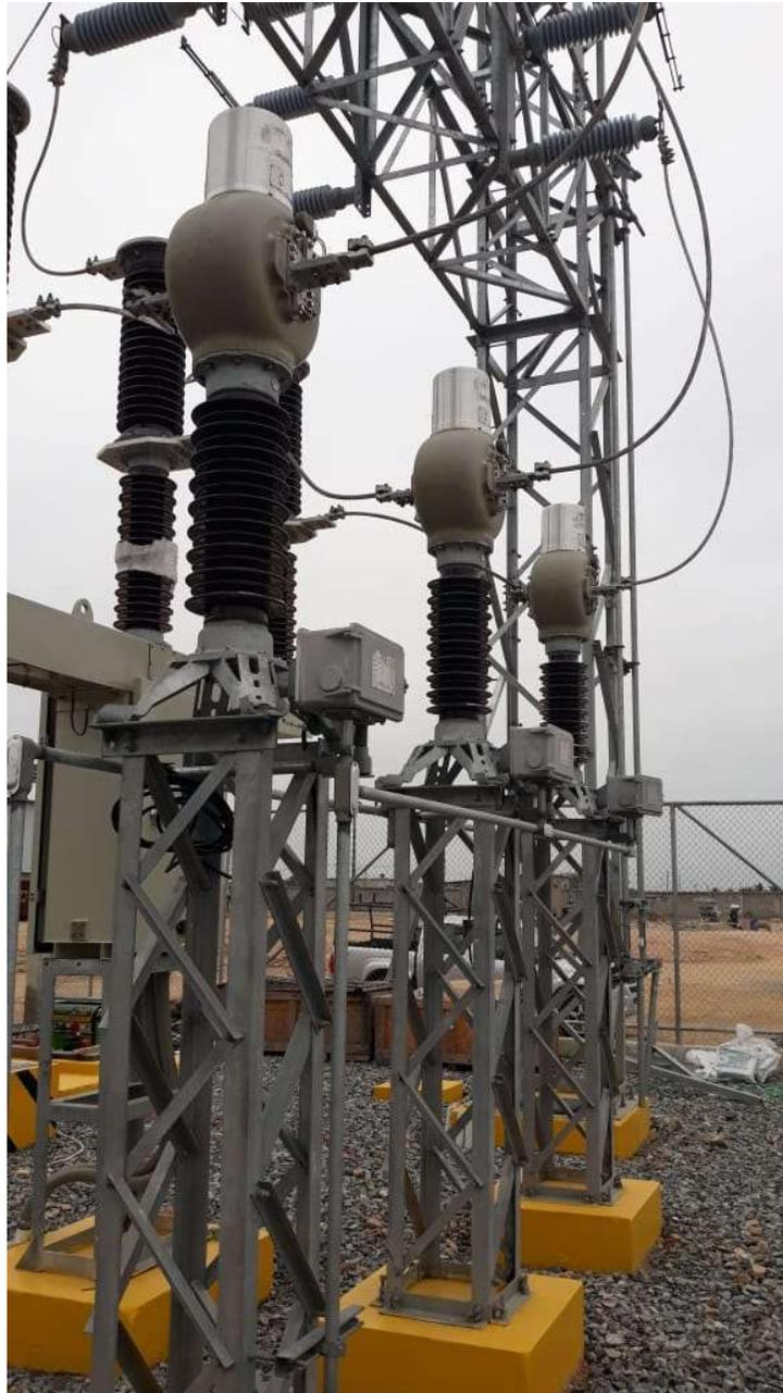
FIGURA 2.14 TRANSFORMADORES DE CORRIENTE
