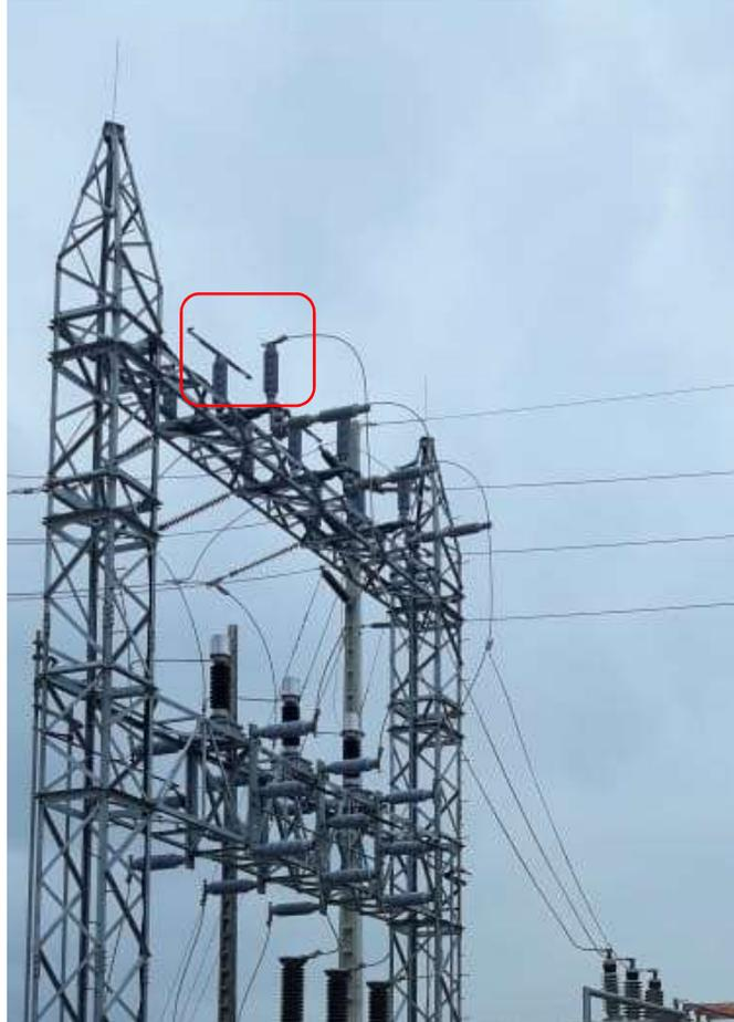
FIGURA 2.2 SECCIONADORES TRIPOLARES
