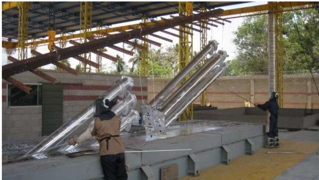
**FIGURA 2.24 GALVANIZACIÓN EN CALIENTE**
