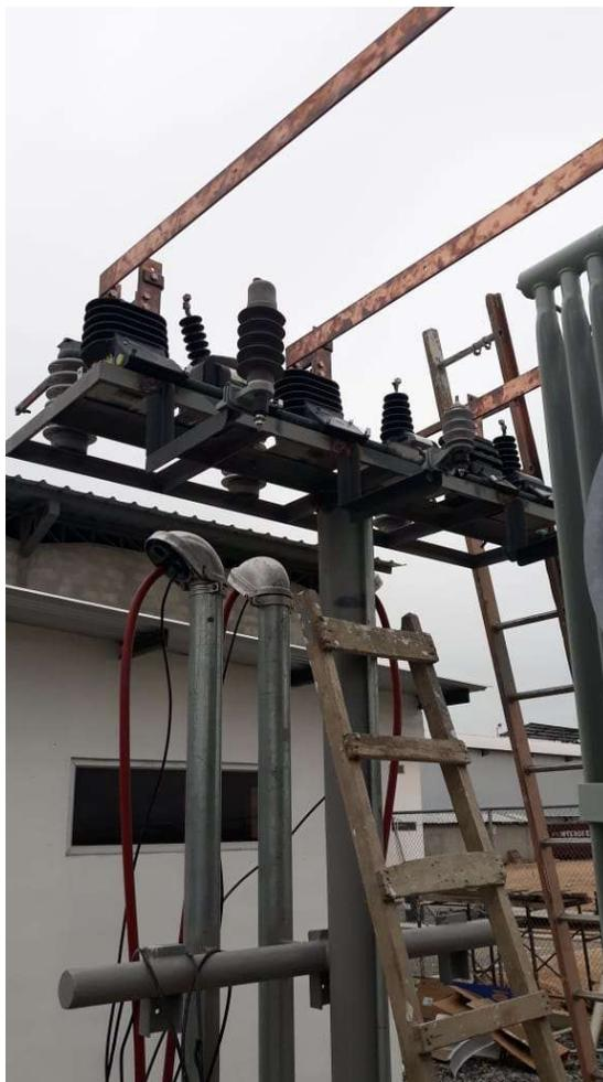
FIGURA 2.13 DESCARGADORES A 10 KV
