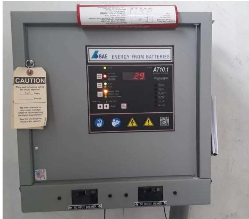
FIGURA 2.27 TABLERO DE SERVICIOS AUXILIARES DC
