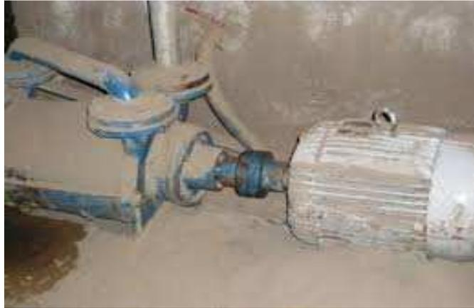
Figura 2. 8 Motor eléctrico funcionando en ambiente contaminado por polvo/suciedad
