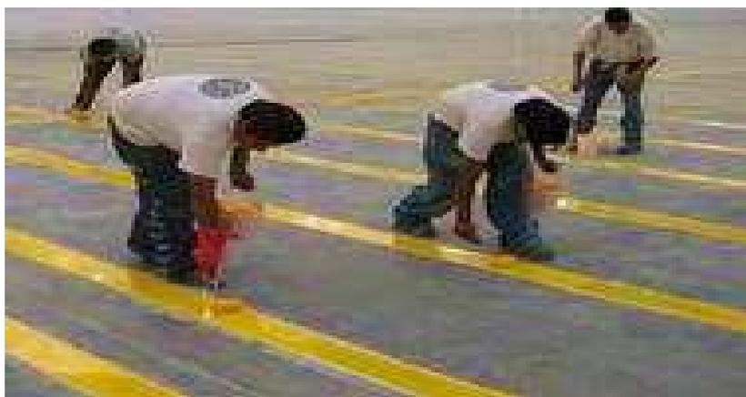
**Figura 16.** Imagen de pintura para señalizar el área
