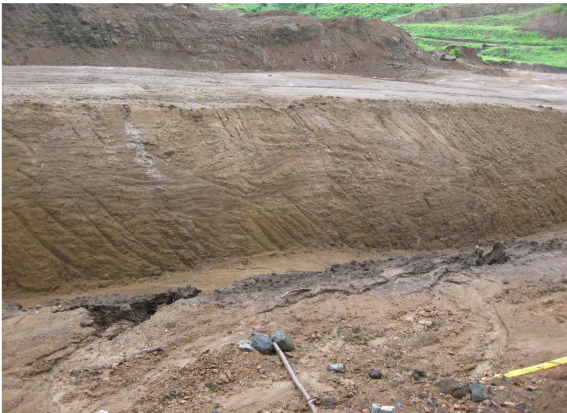
Foto #4: Detalle de Formación Rocosa de Areniscas, en zona de excavación de Dentellón de Presa
