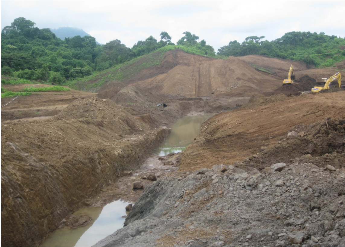
Foto #7: Presencia de nivel freático en trabajos de excavación para la cimentación del núcleo.
