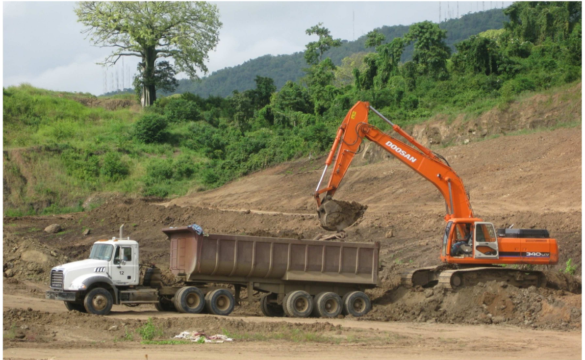
Foto #26: Equipo Combinado utilizada en Obra
