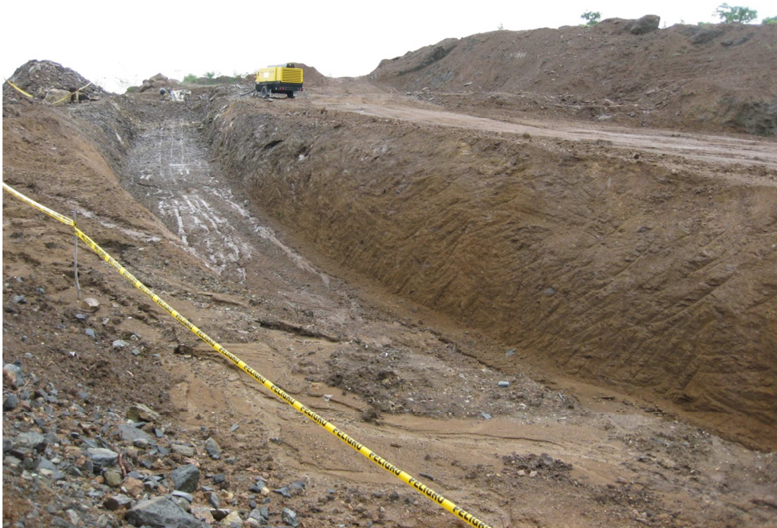
Foto #3: Detalle de Excavación en Roca del Dentellón del Núcleo de la Presa
