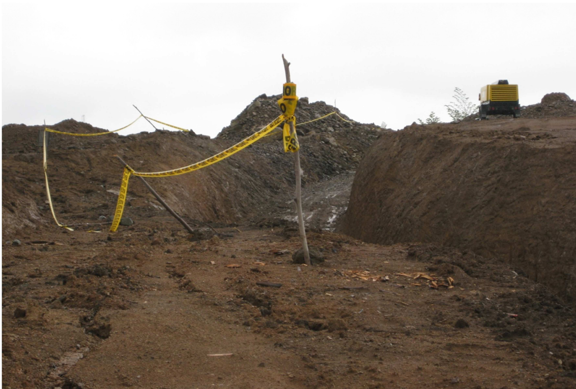
Foto #6: Detalle de Excavación en Suelo de la Base de los Espaldones de la Presa.
