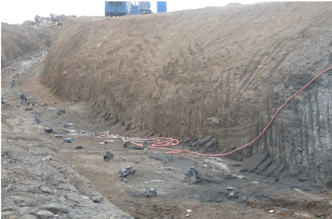
Foto #8: Perforaciones previas a la inyección de lechada de hormigón para la formación de la Pantalla de Hormigón contra futuras infiltraciones.
