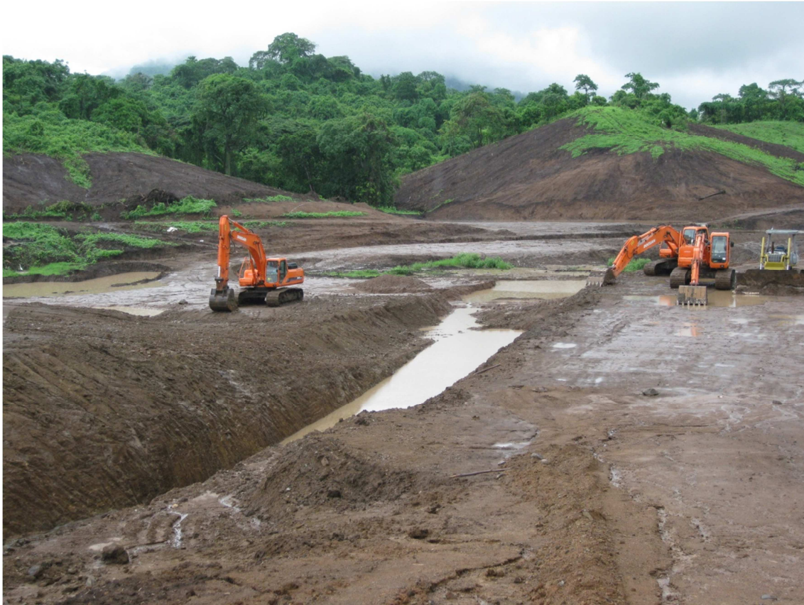
Foto #5: Detalle del Emplazamiento General de la Presa de Tierra de la ESPOL
