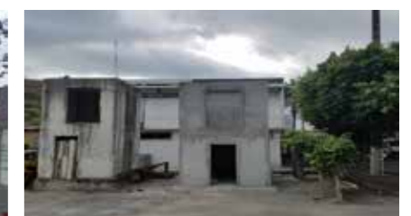
Vista hacia el Este
