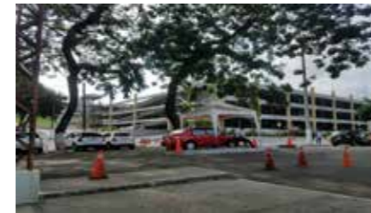
Foto 1. Vista hacia el Edificio de Parqueo
