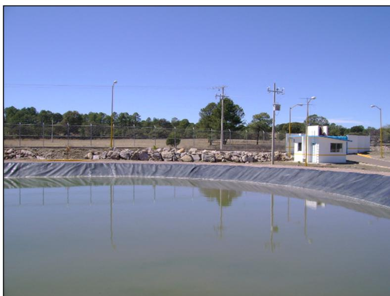
**FOTO 4.- SISTEMA DE LAGUNAS DE ESTABILIZACION EN CAJAMARCA (PERU)**
