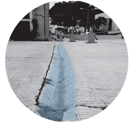
1. Canal de escurrimiento de aguas lluvias
