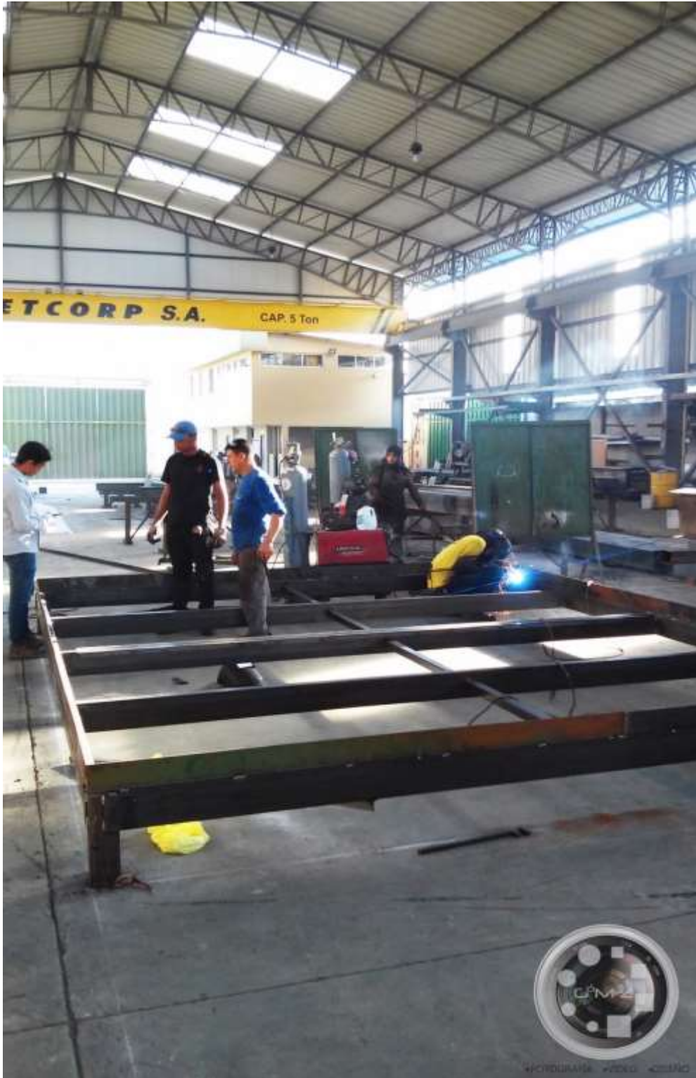
Figura 11. Fotografía fabricación y ensamble de estructura metálica.
