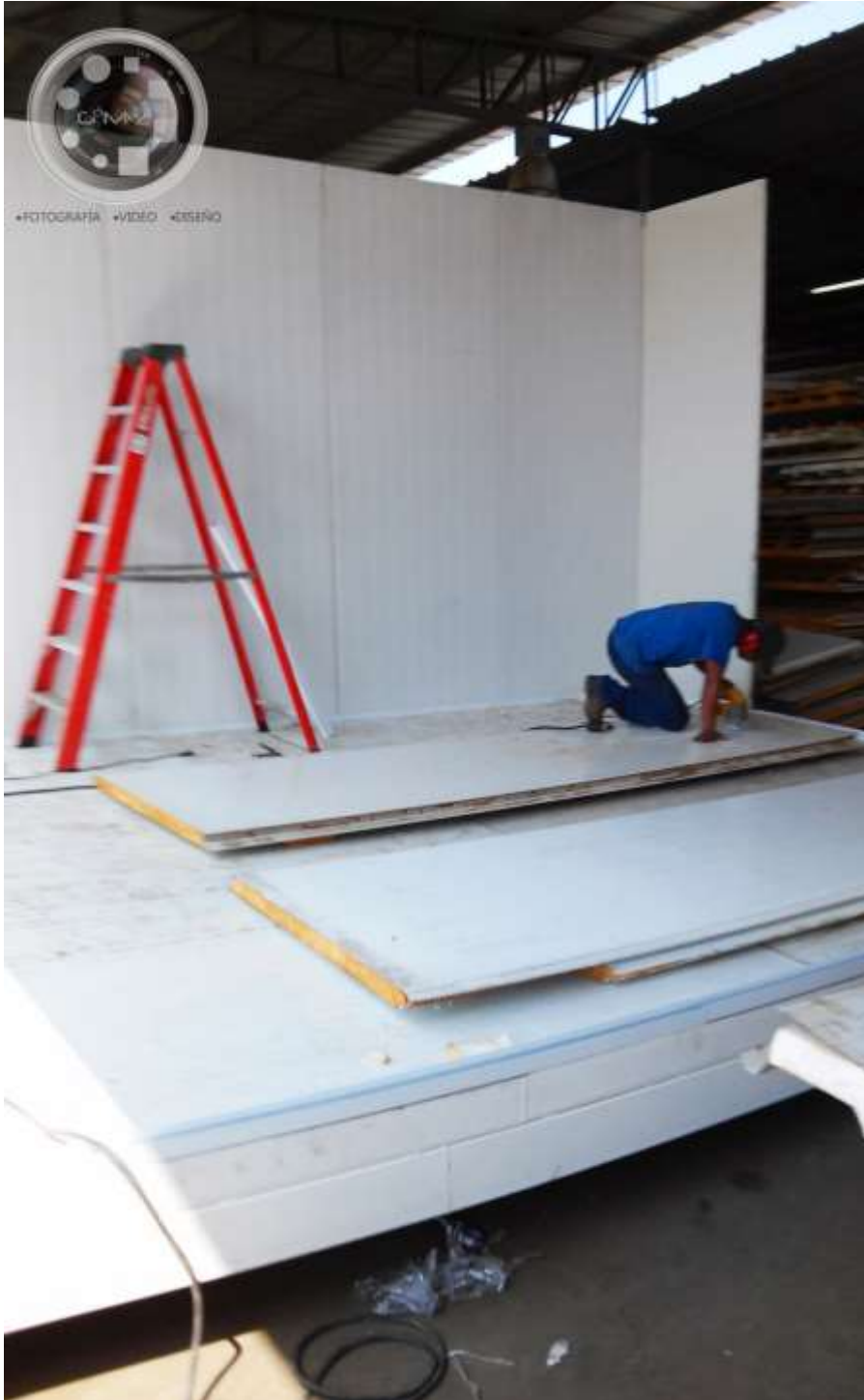
Figura 13. Proceso de corte y ensamble de los paneles de poliuretano.
