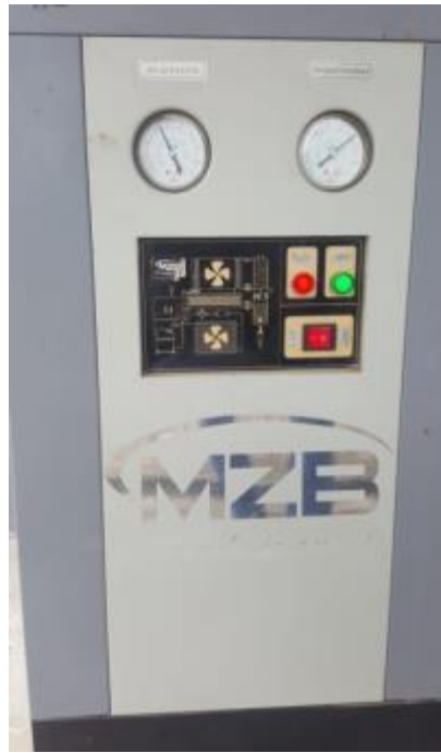
Figura 43. Secador del compresor
