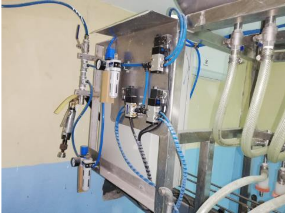
Figura 49. Unidad de mantenimiento y válvulas de maquina embotelladora
