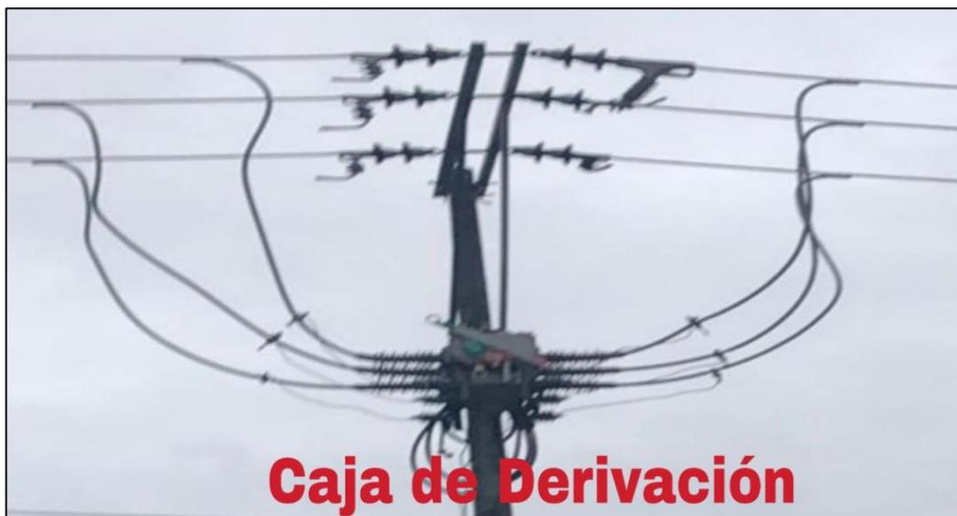
Figura 2.15: Caja de derivación
