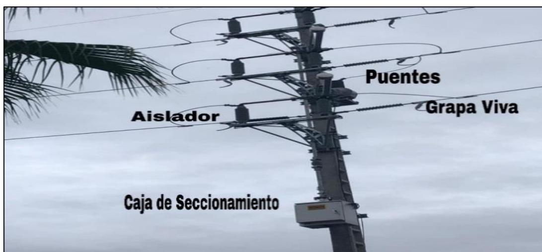
**Figura 2.14: Cajas de seccionamiento**
