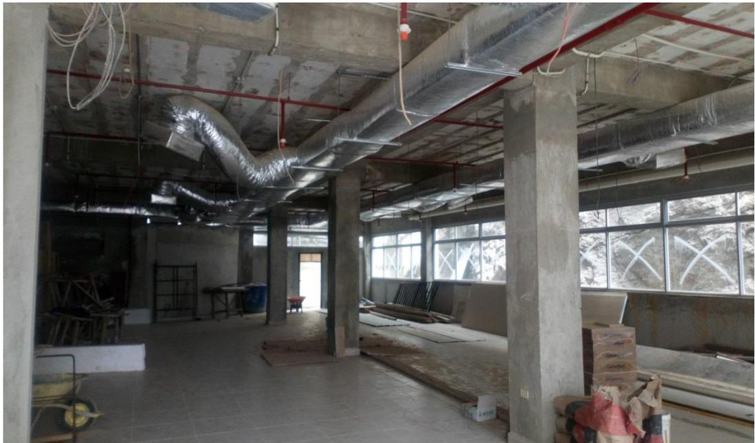
Anexo 4: Distribución de ducto principal y mangas flexibles de aire acondicionado en planta baja.
