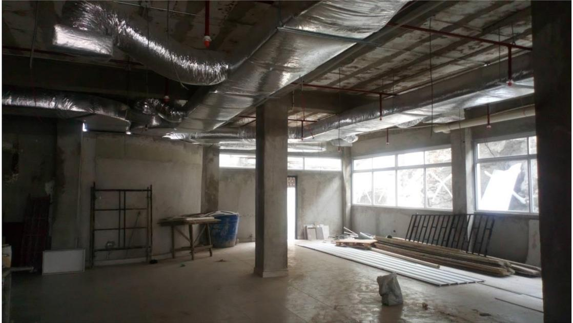
Anexo 3: Distribución de ductos de aires acondicionados tipos paquete ubicado en planta baja.
