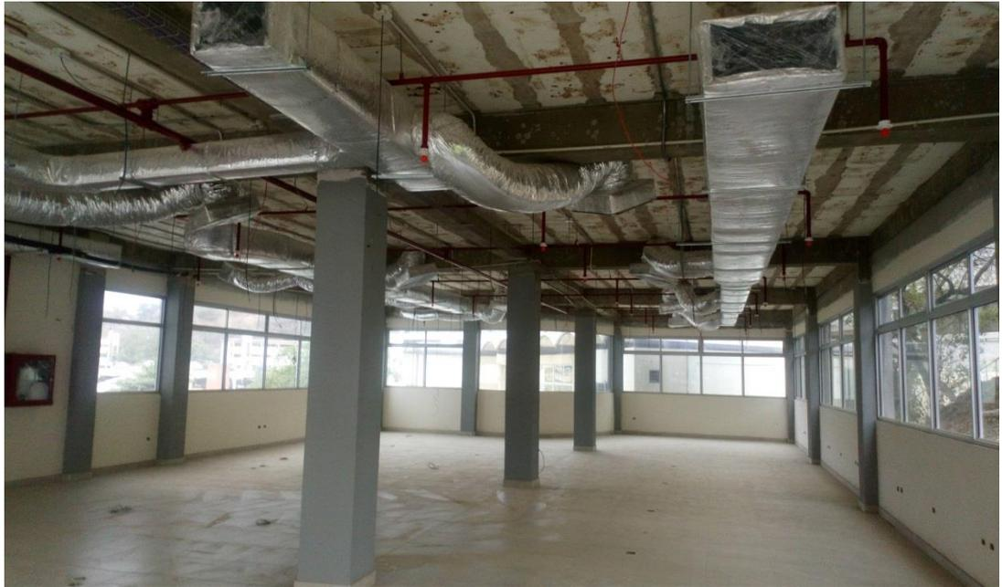
Anexo 5: Distribución de ductos para manejadora tipo fancoil VRF, ubicados en el 1er piso alto.
