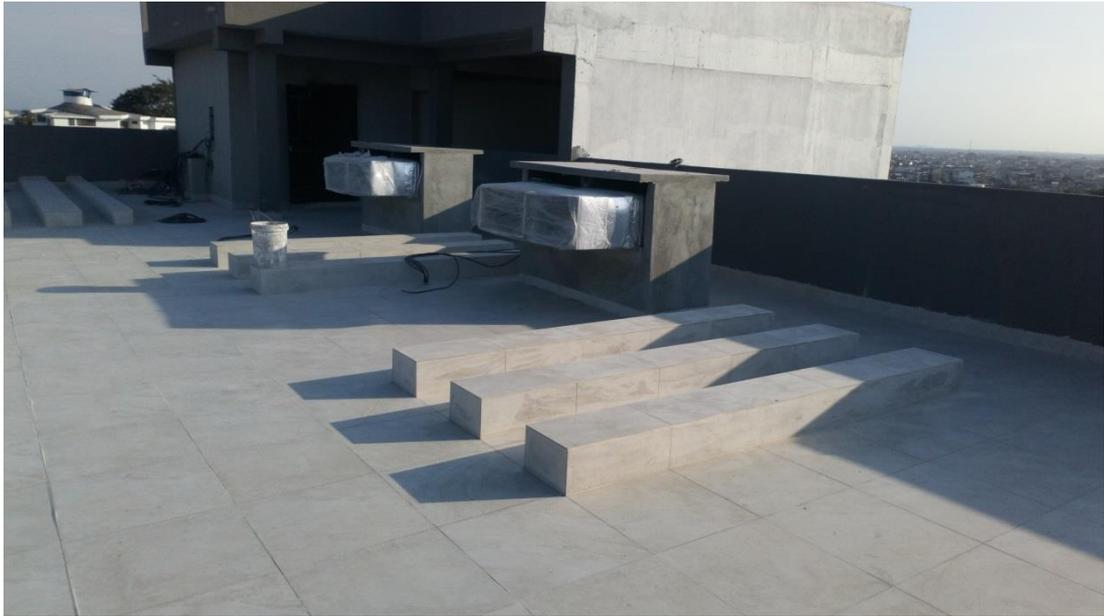
Anexo 9: Bases de hormigón para aire acondicionado tipo paquete en el 4to piso.
