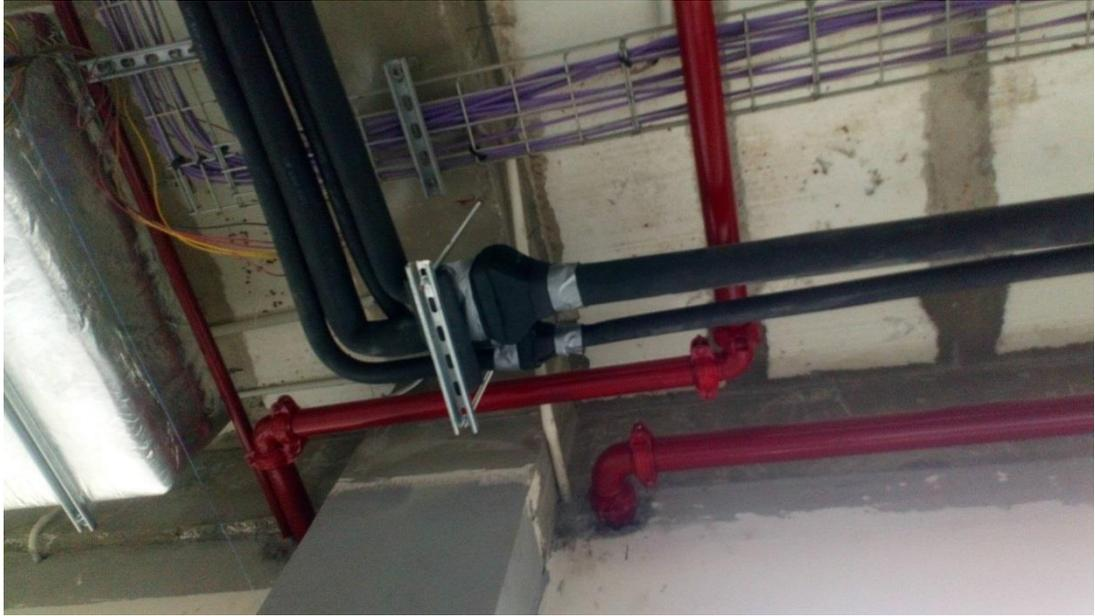
Anexo 7: Sistema de recorrido de tuberías Branch de derivación de tubería.
