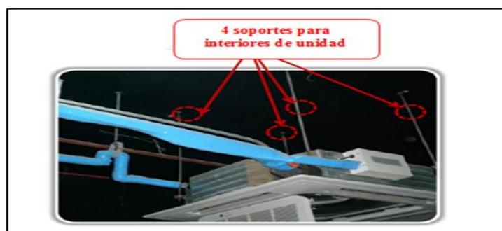
Figura 3. 17 Montaje de unidad interior
