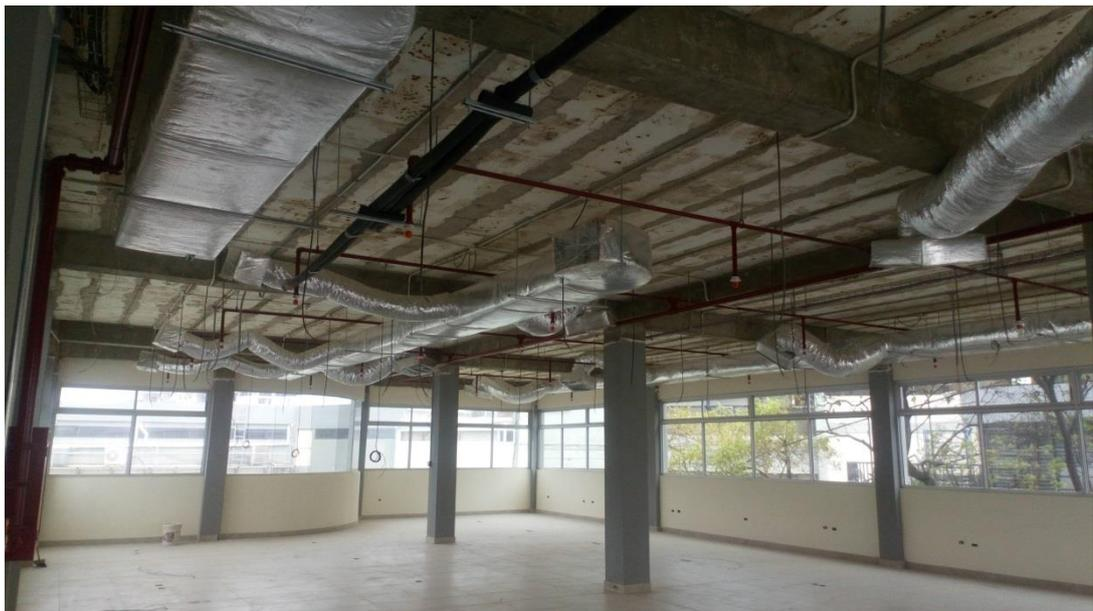
Anexo 6: Distribución de ductos de mando y retorno para manejadora en el 1er piso alto.
