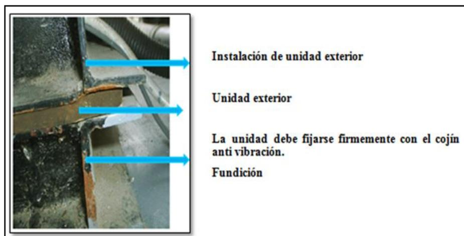
Figura 3. 20 Instalación de la unidad exterior
