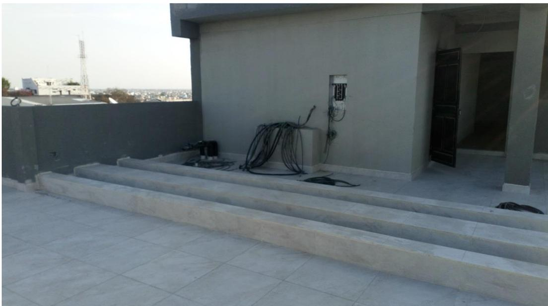
Anexo 10: Bases de hormigón para unidades condensadoras y sistema eléctrico de los 4 sistemas VRF.
