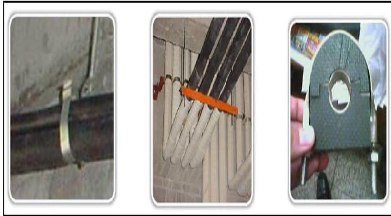
Figura 3. 22 Sistema de anclaje y aislamiento térmico
