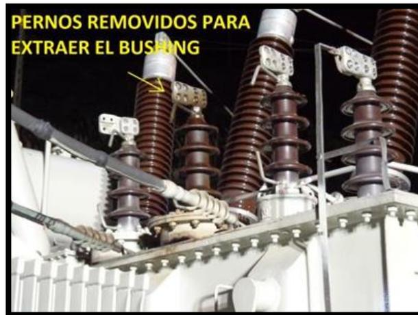
Figura 63: Cambio de bushing del transformador de potencia
