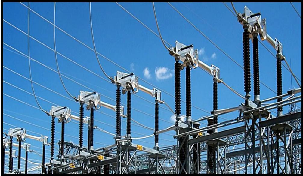
Figura 12: Cuchillas desconectoras de apertura vertical/corriente 2000A
