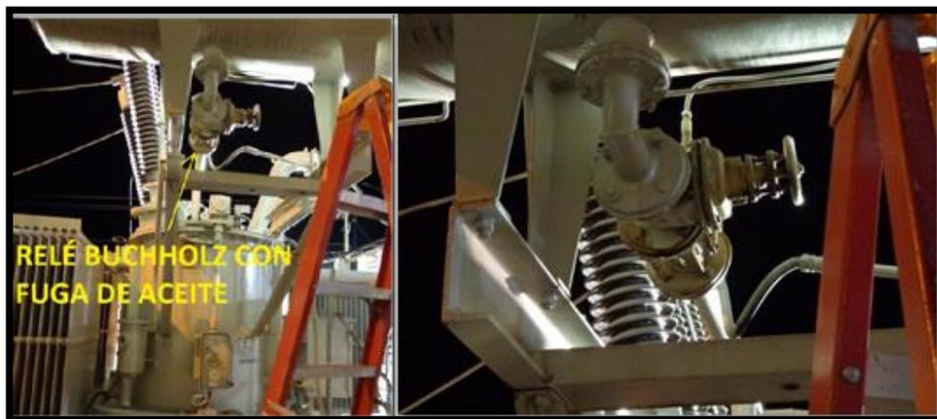
Figura 56: Relé Bulchholz con fuga de aceite
