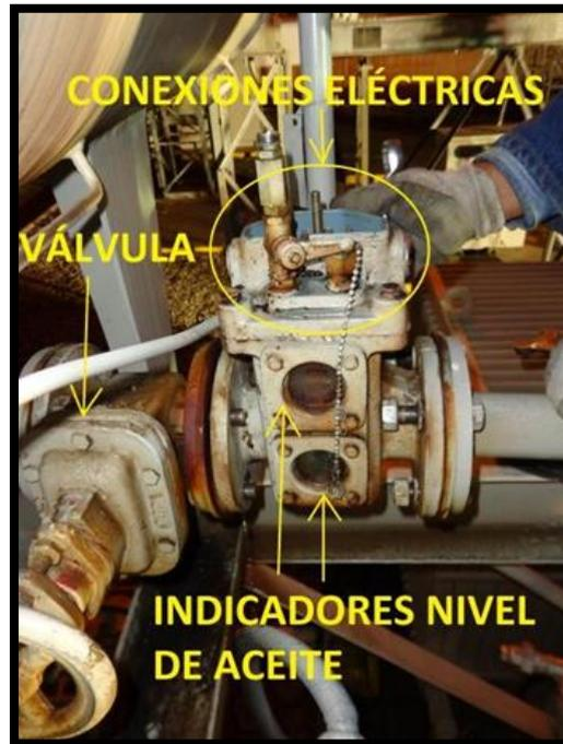
Figura 57: Bornes de conexiones eléctricas, válvula e indicadores de nivel de aceite del Relé Bulchholz
