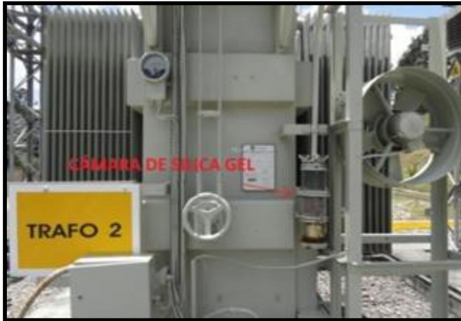
Figura 60: Cámara del silicagel en transformador
