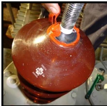
Figura 64: Se aplica silicón a terminal de bushing para evitar fuga de aceite
