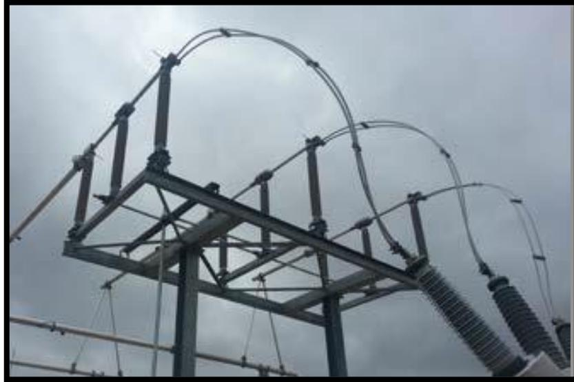
Figura 15: Seccionador de apertura central 69kV
