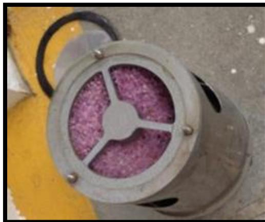
Figura 61: Silicagel color rosado/necesita reemplazo
