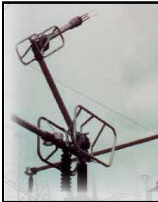
Figura 14: Seccionador tipo semipantógrafo
