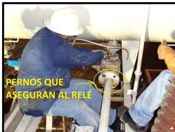
Figura 58: Pernos que sujetan al Relé Bulchholz
