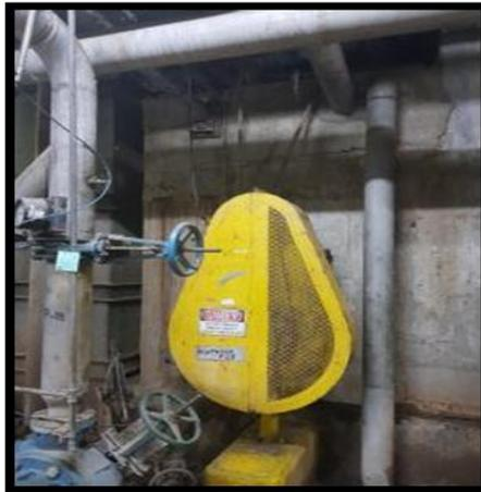
Figura 3. 4 Motor agitador tanque deflaking
