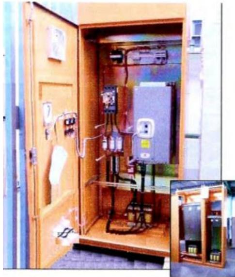
Figura 2. 34 Tablero de arrancador de motor con variador de velocidad: Protección total
