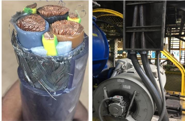
Figura 2. 20 Cable apantallado y motor conectado a variador
