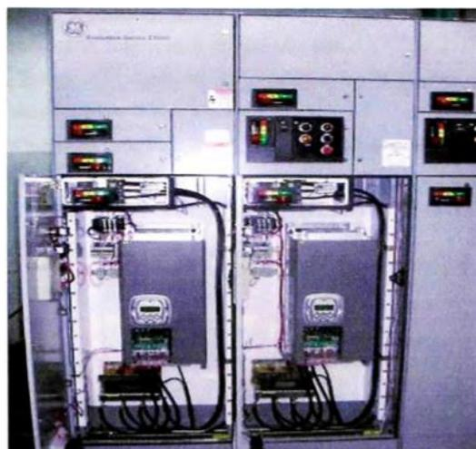
Figura 2. 30 Instalación de un arrancador con variador en un centro de control de motores Fuente. (Mamani Conto, 2011, pág. 30)
