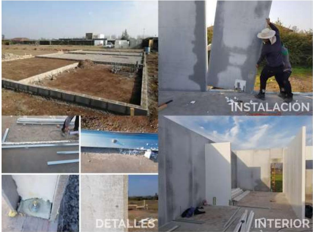
**Ilustración 9: Proceso constructivo de obra con paneles con placa de óxido de magnesio.**
