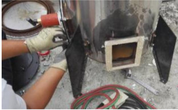
**Figura 3. 4.** Armado del puerto de cenizas y del agitador manual de rejilla
