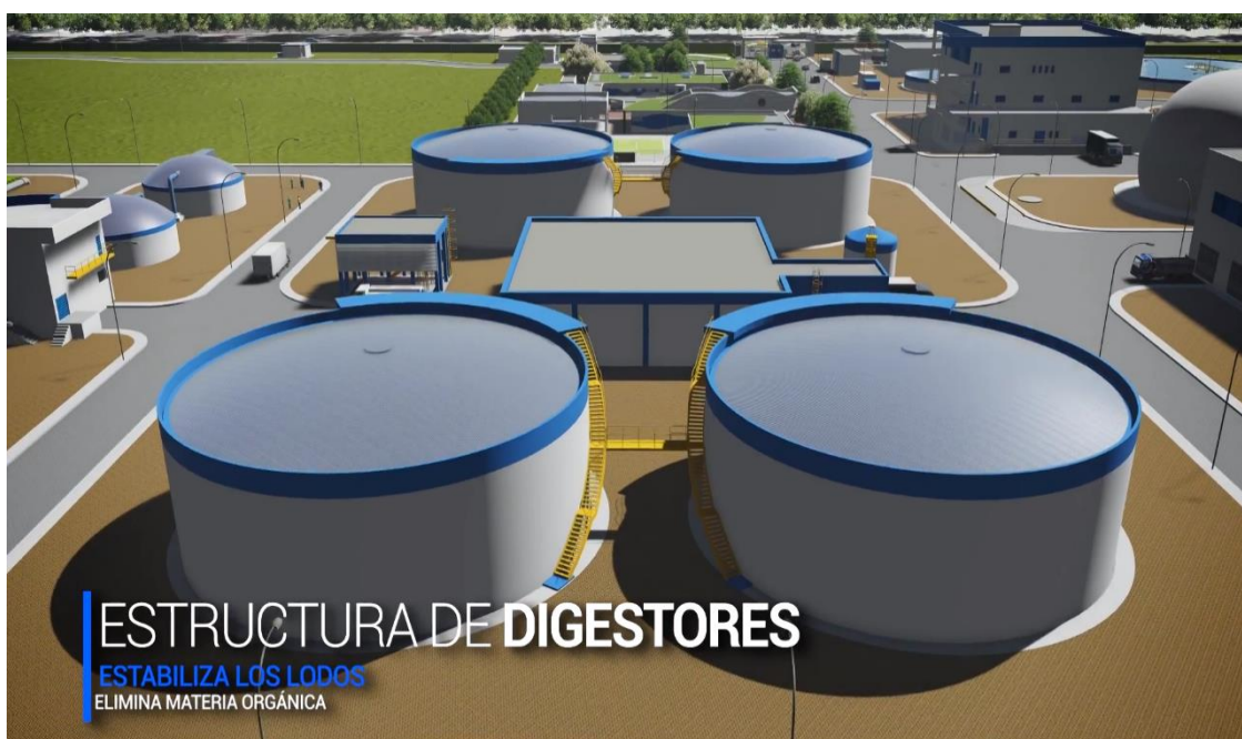
Figura 3. 12 Estructura de digestores. Fuente: (Secretaría del Agua, 2017)
