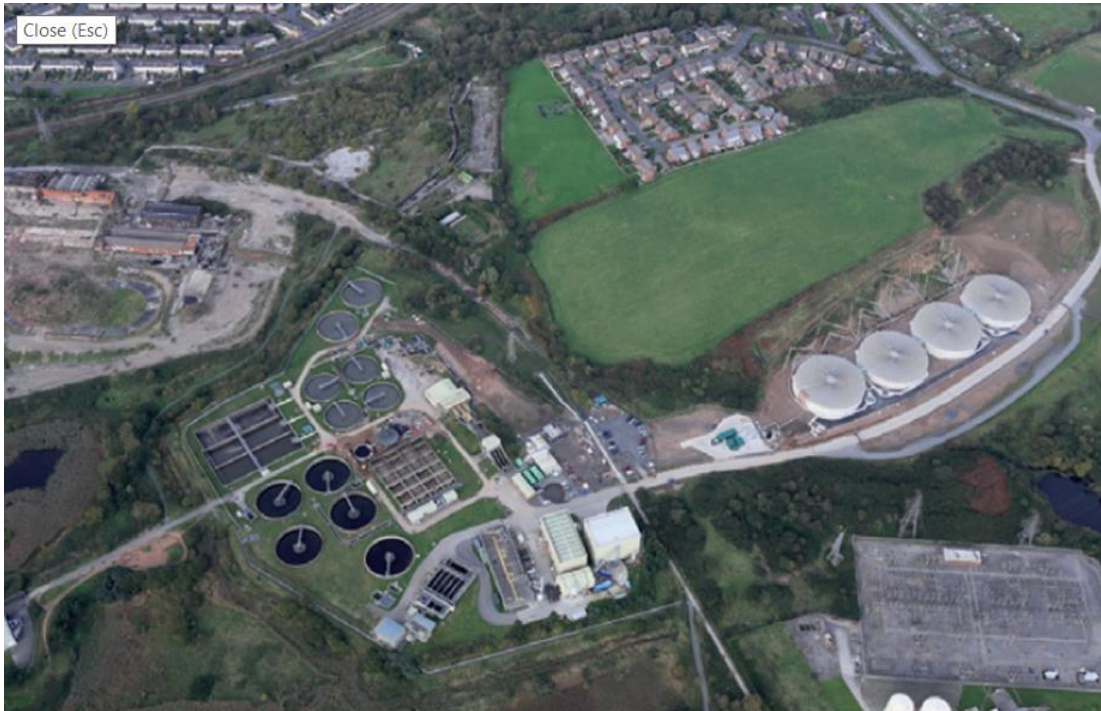
Figura 2. 7 Planta de tratamiento de Aguas Residuales. Fuente: (TES Water, 2014)
