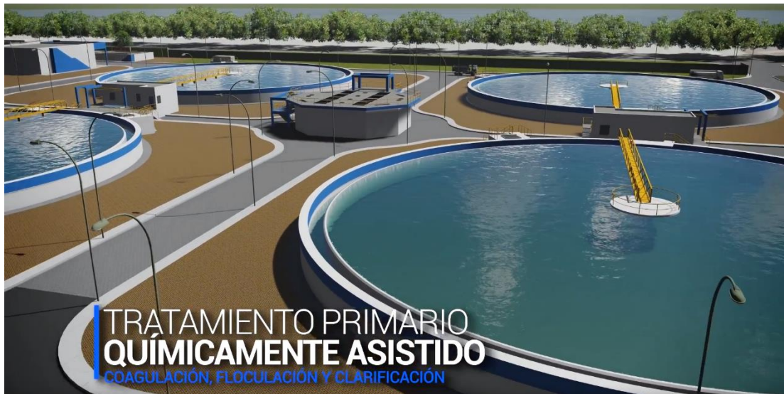
Figura 3. 8 Tratamiento primario químicamente asistido. Fuente: (Secretaría del Agua, 2017)
