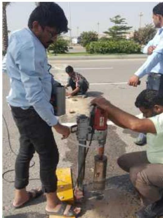
Figura 3. 15: Perforación de la calzada
