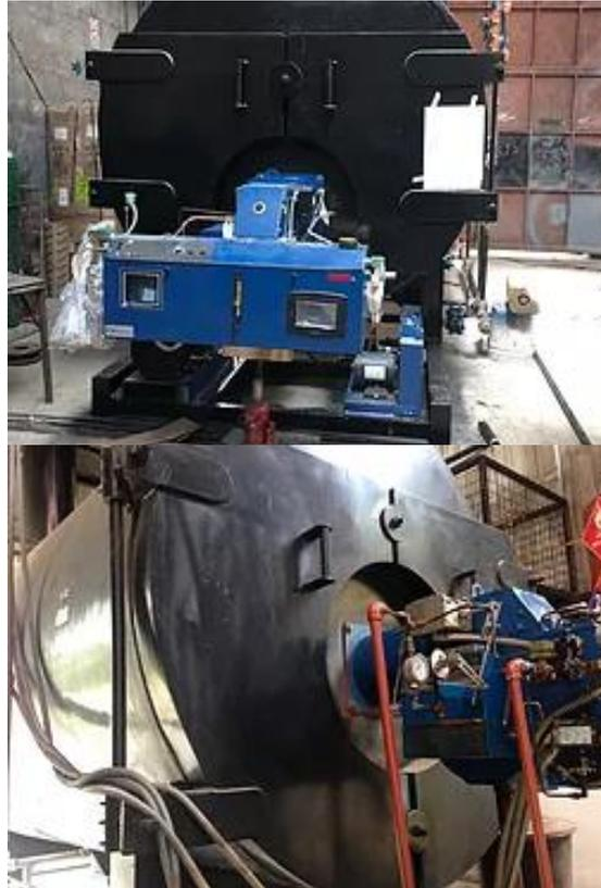
*Figura 11 Caldera de Vapor Thermocon HRSG*
