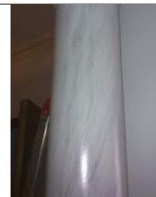
Figura 138: columnas de escayola en imitación a mármol Fuente: pinturas lleni (2011)
