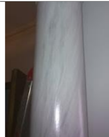
Figura 112: columnas de escayola en imitación a mármol Fuente: pinturas lleni (2011)
