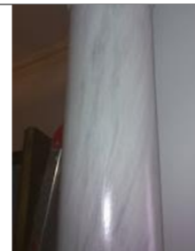
Figura 156: columnas de escayola en imitación a mármol Fuente: pinturas lleni (2011)
