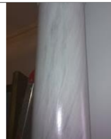
Figura 126: columnas de escayola en imitación a mármol Fuente: pinturas lleni (2011)
