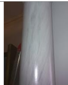
Figura 147: columnas de escayola en imitación a mármol Fuente: pinturas lleni (2011)
