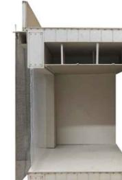
d Se sujeta exteriormente de las vigas del primer y tercer piso por medio de placas metálicas.
