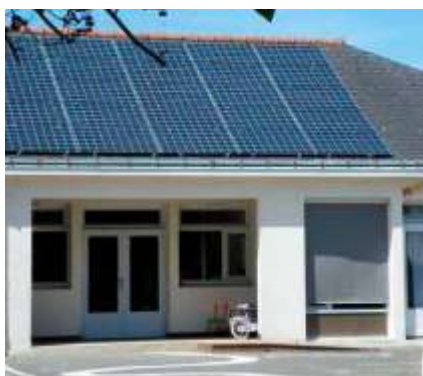
Figura 18. Paneles fotovoltaicos en una escuela
