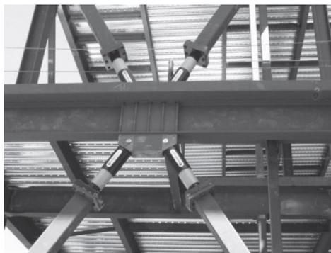
Figura 3.3.4.3 Disipadores de fluido viscoso instalados en los arriostramientos diagonales. (Chopra 2012)
