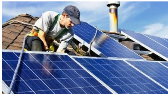
Figura 2. 29: Montaje de un sistema de paneles solares en el techo de un hogar. Fuente: (Boxwell, 2017)
