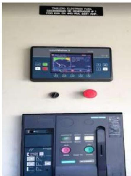
*Figura 4. 9 Tablero del Sistema de sincronización G#1*
