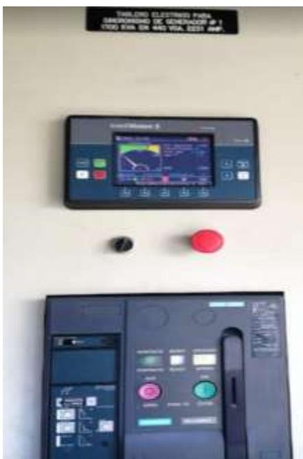
*Figura 4. 10 Tablero del Sistema de sincronización G#2*
