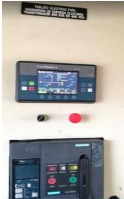
Figura 4. 12 Sistema de sincronización con sistema eléctrico del transformador de 850 kva
