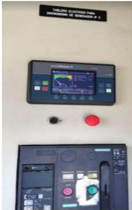
*Figura 4. 11 Tablero del Sistema de sincronización G#3*
