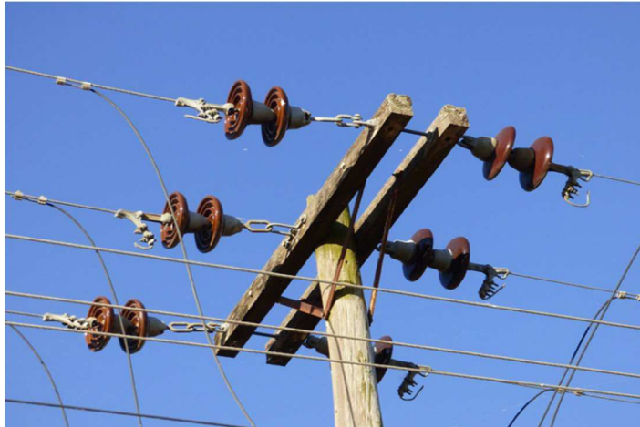
Figura 4. 4 Aisladores tipo cadena para media tensión Fuente: (Structulia, 2018)
