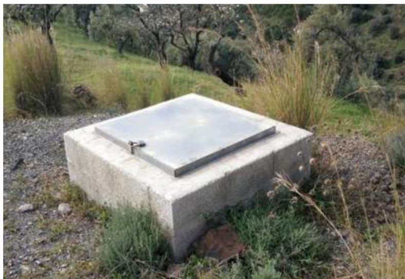
Figura 2. 11 Ejemplo de cómo sellar un pozo abandonado Fuente: (20 MINUTOS EDITORIALI S.L., 2019)
