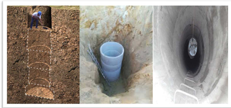
Figura 2. 2 Proceso de elaboración de excavación de pozos abiertos Fuente: (GARCIA, 2015)
