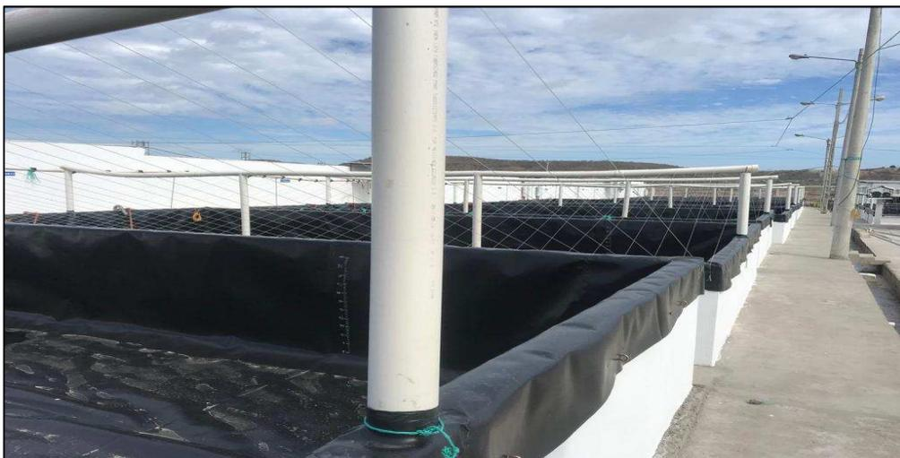
Figura 3.8. Tanques de concreto recubiertos con *liner*
