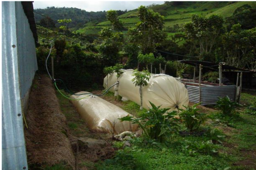
Figura No. 4 Biodigestor de bajo costo tubular de polietileno instalado en Costa Rica.
