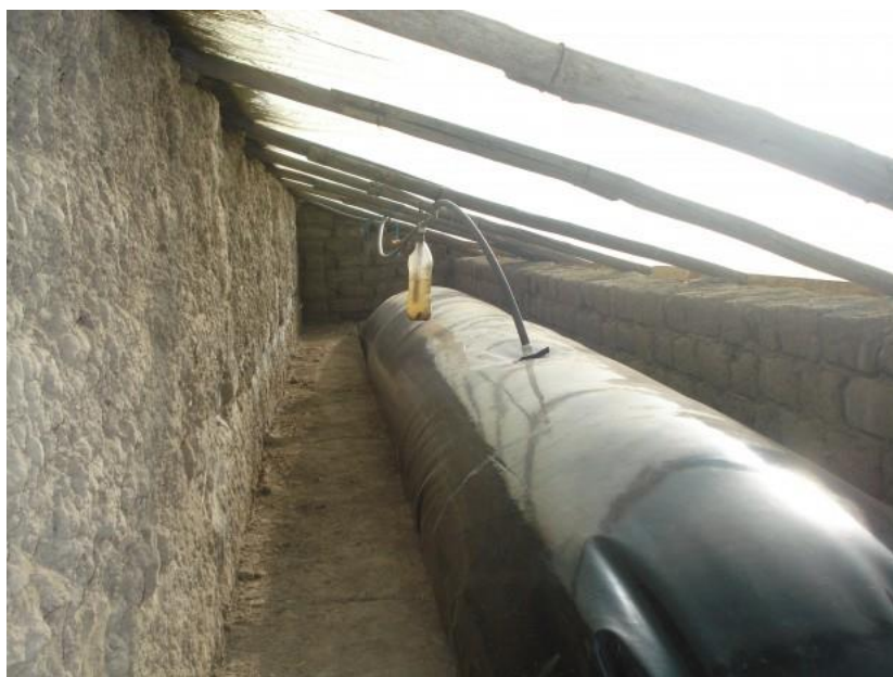
Figura No. 5 Biodigestor de bajo costo tubular en clima frio, vista interior del invernadero. Bolivia
