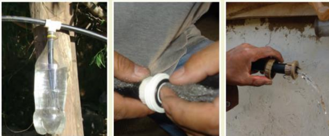
Figura No. 9 Proceso de mantenimiento de un biodigestor
