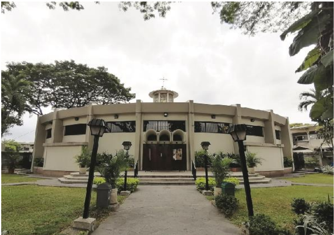
Figura 51 Fotografía fachada de la iglesia.
