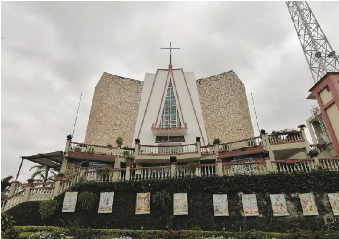
Figura 23 Fachada Iglesia San Antonio de Padua.
