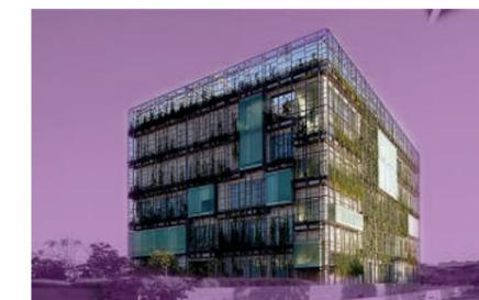
La fachada se inspira en la idea de una doble piel que permite una modulación de la luz y el aire a través del edificio.
