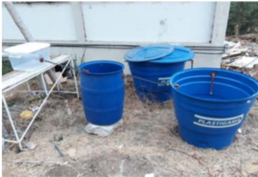
Ilustración 15 Planta piloto instalada
