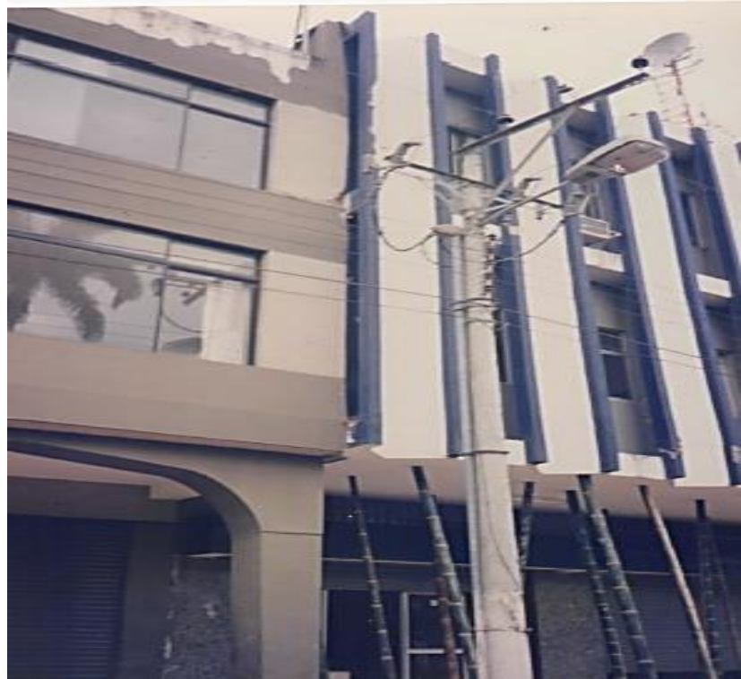
Ilustración 7. Adosamiento entre estructuras. Fuente: Ing. Alex Villacrés, 1998
