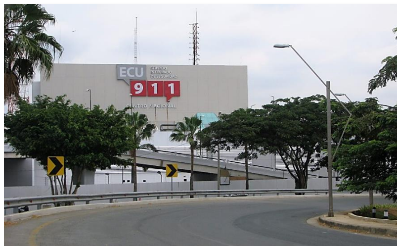
Ilustración 14. Edificio ECU-911 Samborondón. Tomada de: “El Universo”, 2016.
