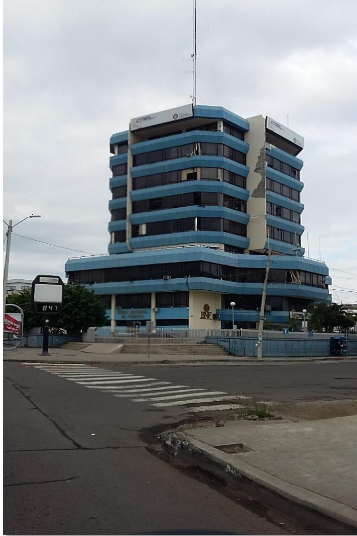
Ilustración 30. Edificio CNEL de Manta después del sismo. Fuente: Ing. Alex Villacrés, 2016.
