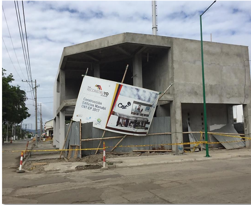
Ilustración 40. Actual edificio CNT Bahía de Caráquez. Tomado por el autor, 2019.
