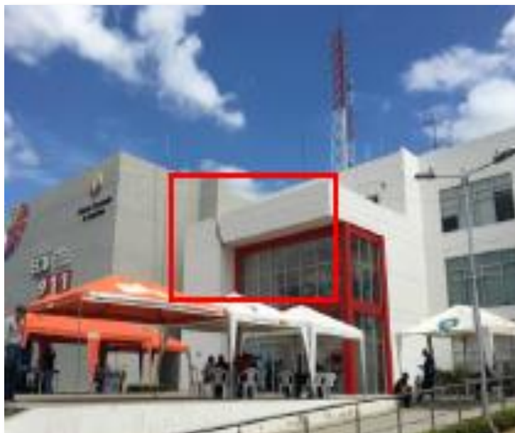
Ilustración 17. Edificio ECU-911 Portoviejo después del sismo de 2016. Tomado de GEER-ATC. Earthquake Reconnaissance, 2016.
