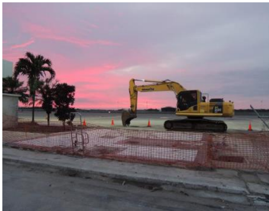
Ilustración 22. Localización de la torre de control aérea Eloy Alfaro. Fuente: GEER-ATC. Earthquake Reconnaissance, 2016.
