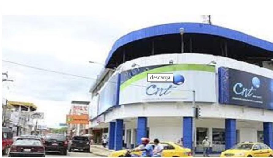
Ilustración 26. Edificio CNT Portoviejo. Tomada de: “El Diario”, 2016.
