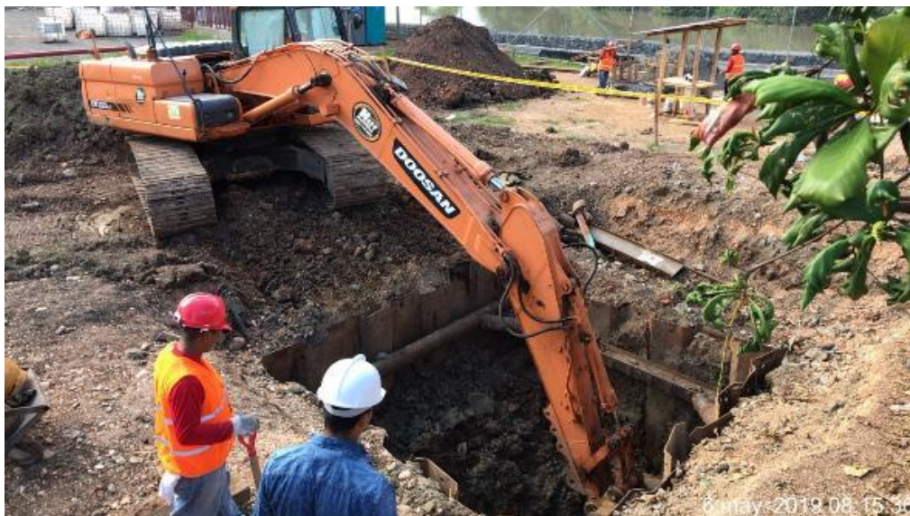
Figura 42. Maniobra del brazo de la excavadora. Por C. Fajardo. (Durán, 2019).
