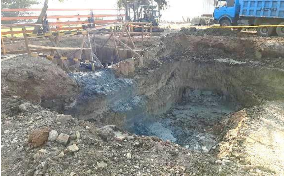
Figura 56. Segunda parte de la excavación de la PTAR. Elaboración Propia.
