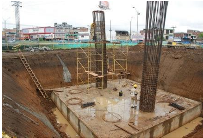
Figura 16. Excavación para cimentaciones profundas. Recuperado de http://www.eadic.com/tipos-de-cimentacion-descripciones/
