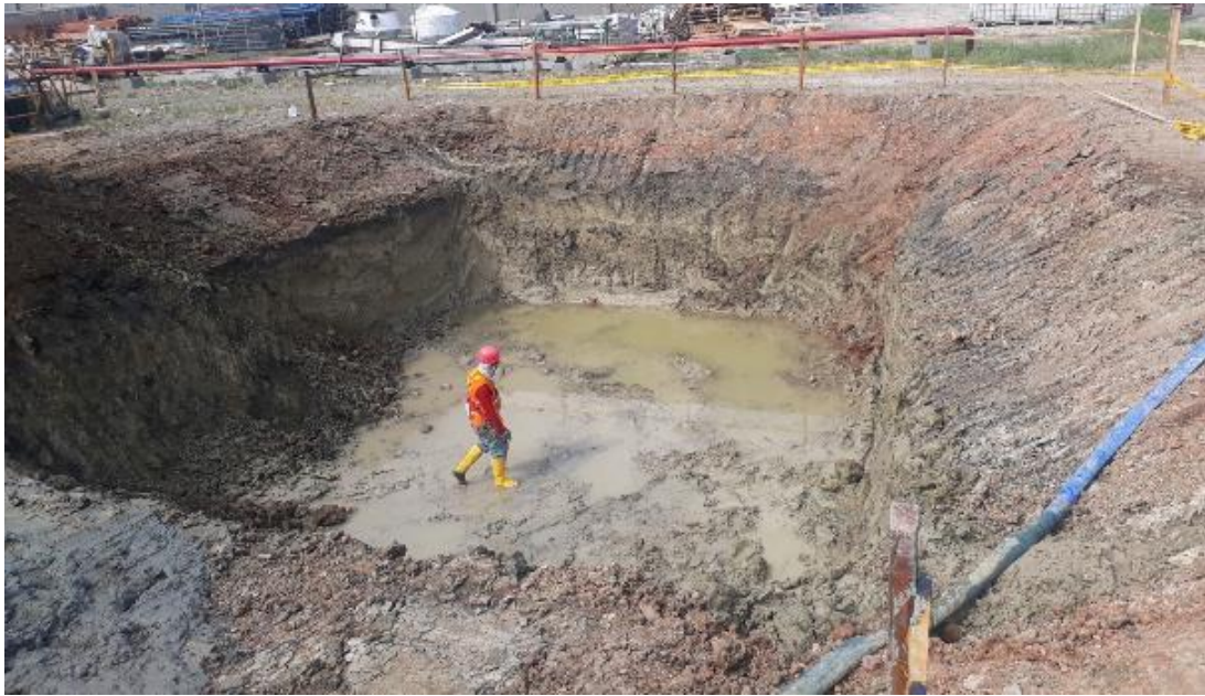
Figura 54. Conformación del talud en la excavación de la PTAR. Elaboración Propia.
