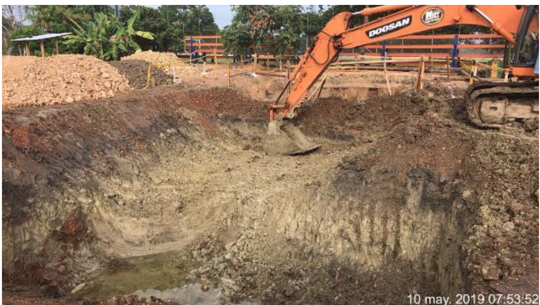
Figura 53. Área de excavación junto al tablestacado del pozo de bombeo. Por C. Fajardo. (Durán, 2019).
