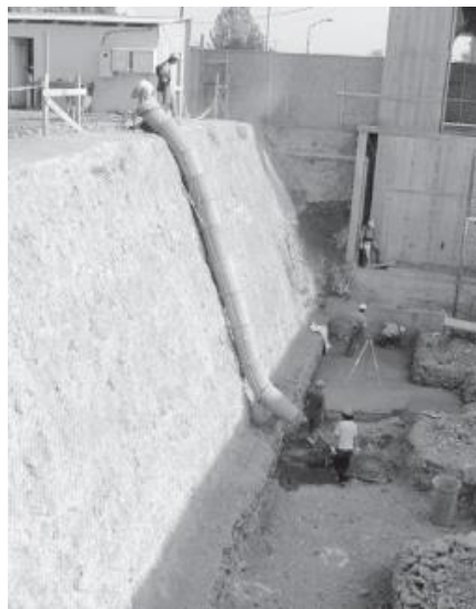
Figura 25. Talud protegido con hormigón proyectado. Recuperado de “Procesos y Técnicas de Construcción”, de Solminihaç, T.H.D., & Thenoux, Z.G. (2011), p. 279, Chile.
