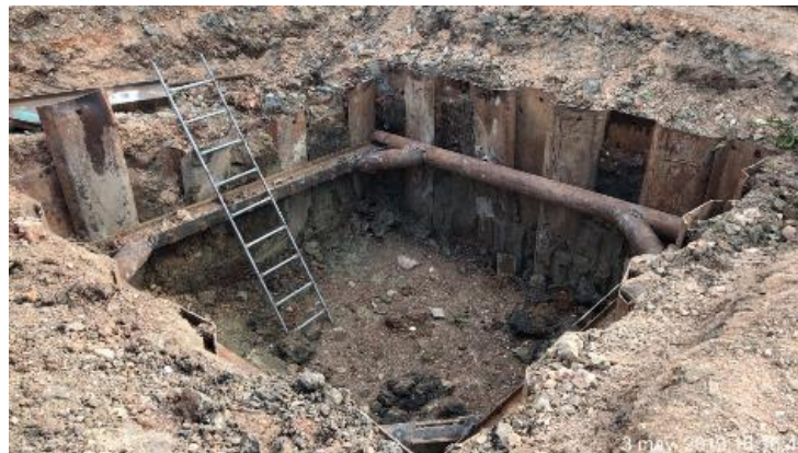
Figura 44. Anillos colocados en el tablestacado para dar mayor seguridad para el empuje lateral de la tierra. Por C. Fajardo. (Durán, 2019).
