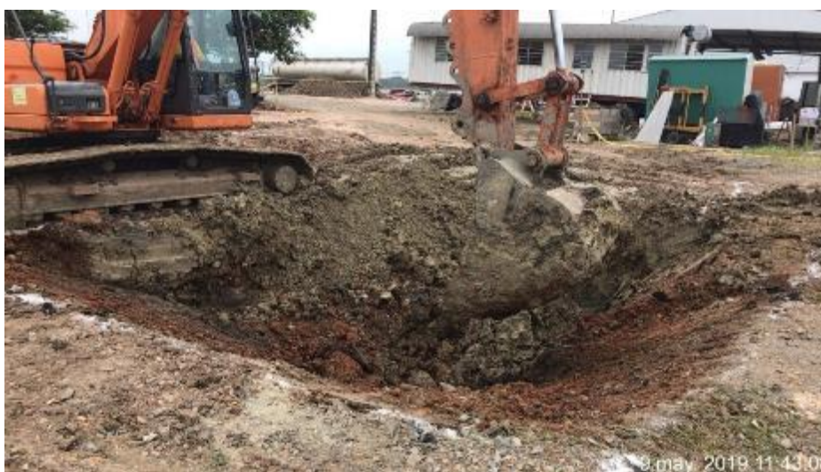
Figura 48. Trazado y Excavación de la PTAR. Por C. Fajardo. (Durán, 2019).
