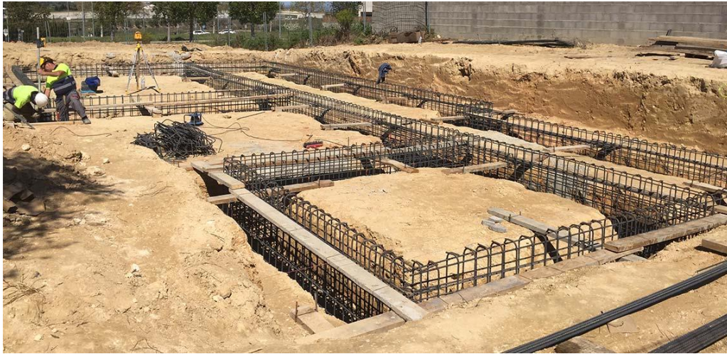
Figura 14. Excavación y armadura para las zapatas corridas de la cimentación. Recuperado de http://www.energiehaus.es/casa-mg-movimientos-tierra-excavaciones-cimentacion-saneamiento/
