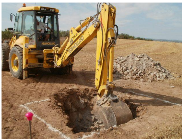
Figura 13. Excavación de una zapata. Recuperado de https://www.arqhys.com/construcciones/excavacion-para-cimientos.html
