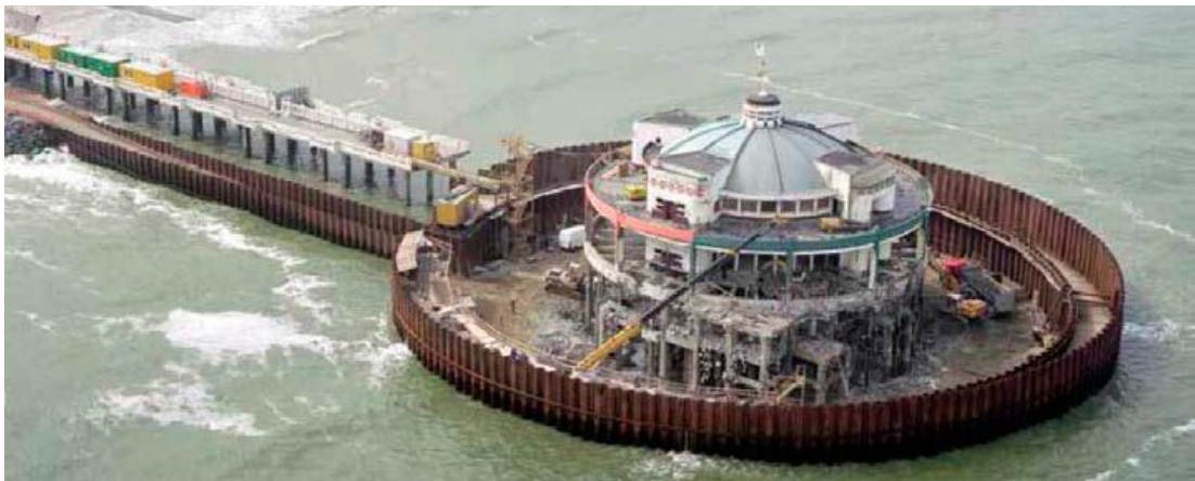
Figura 29. Muelle de Blankenberg, Bélgica, formado por tablestacas metálicas. Recuperado de “Procedimientos de construcción de cimentaciones y estructuras de contención”, de Yepes, V.P., p. 147, España.
