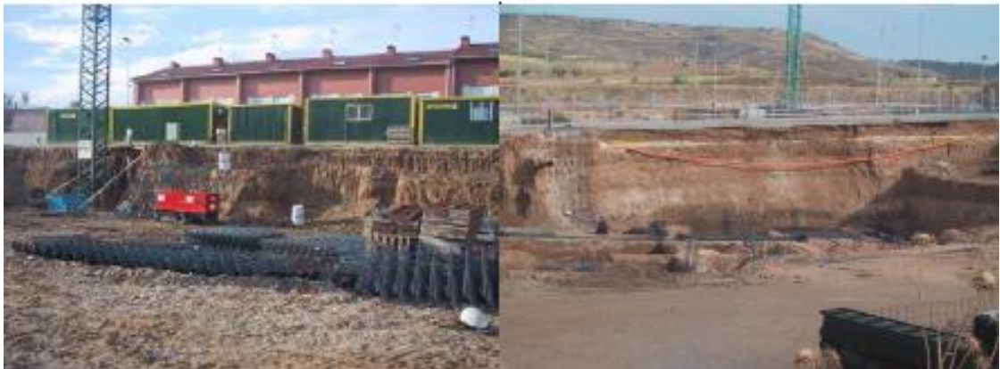
Figura 17. Trabajos de excavación por debajo de la rasante del terreno en ejecución de vaciados. Recuperado de “Las actuaciones en el terreno y la cimentación”, de Amo, P.M.P.D. (2015), p. 55, Madrid.
