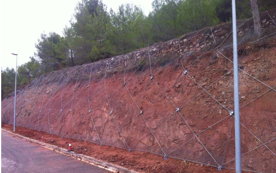
Figura 26. Malla de triple torsión reforzada. Recuperado de http://www.inaces.com/servicios/taludes/mallas-metalicas-triple-torsion/
