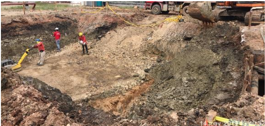
Figura 55. Segunda parte de la excavación de la PTAR. Elaboración Propia.
