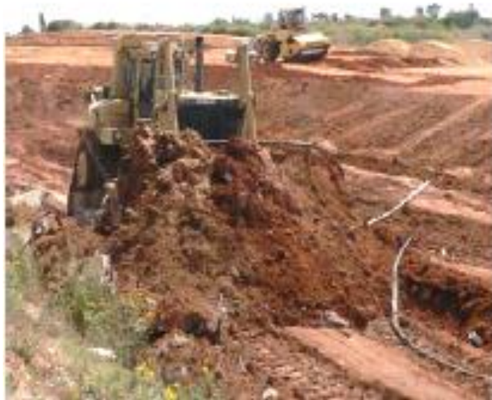
Figura 9. Extracción, carga y transporte de las tierras, en una sola tarea mediante un bulldozer. Recuperado de “Las actuaciones en el terreno y la cimentación”, de Amo, P.M.P.D. (2015), p. 88, Madrid.
