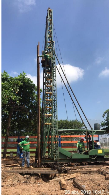
Figura 39. Martinete de Cabrestante para hincar tablestacas. Por C. Fajardo. (Durán, 2019).
