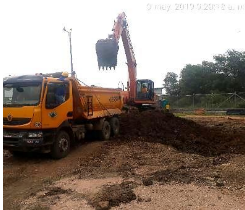
Figura 8. Extracción de la tierra y carga en vehículo de transporte en una misma tarea. Por C. Fajardo. (Durán, 2019).
