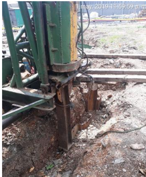
Figura 40. Hincado de la tablestaca con el suplex implementado en el martillo de la máquina. Por C. Fajardo. (Durán, 2019).
