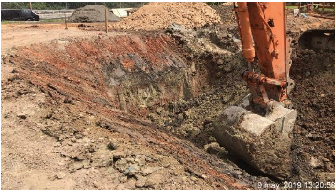
Figura 52. Conformación del talud en la excavación de la PTAR. Elaboración Propia.
