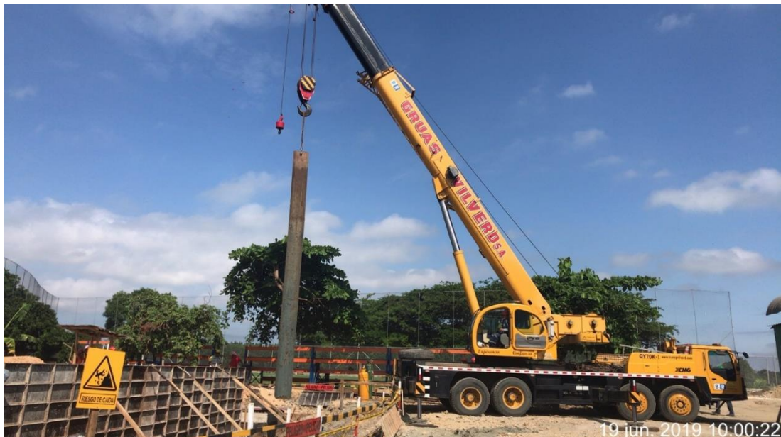
Figura 46. Sacada de la tablestaca mediante una grúa. Elaboración Propia.
