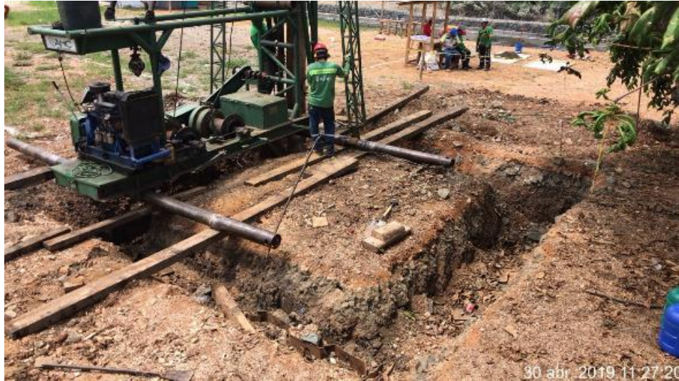
Figura 41. Excavación de 1.50m de profundidad previo al hincado de las tablestacas. Por C. Fajardo. (Durán, 2019).
