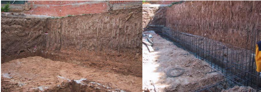
Figura 21. Ejecución del vaciado con corte vertical y posterior ejecución de muro de sótano. Recuperado de “Las actuaciones en el terreno y la cimentación”, de Amo, P.M.P.D. (2015), p. 107, Madrid.
