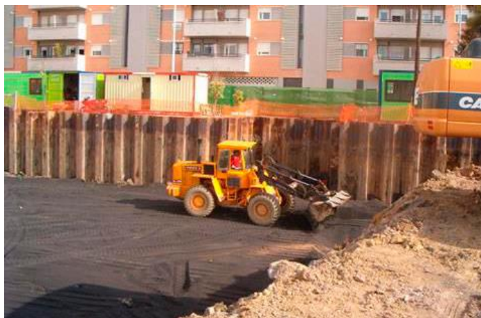
Figura 31. Pantallas de tablestacas autoportantes. Recuperado de “Procedimientos de construcción de cimentaciones y estructuras de contención”, de Yepes, V.P., p. 149, España.
