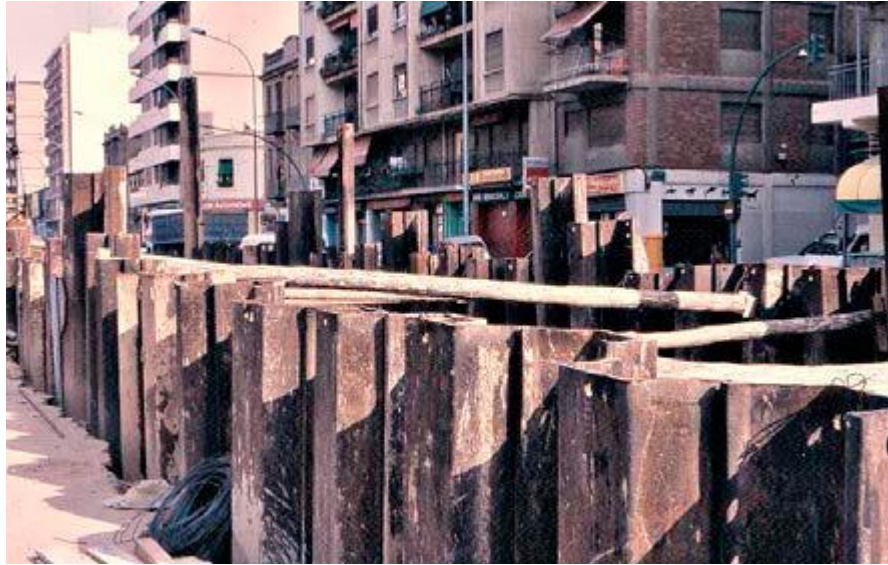
Figura 28. Tablestacas metálicas. Recuperado de “Procedimientos de construcción de cimentaciones y estructuras de contención”, de Yepes, V.P., p. 143, España.
