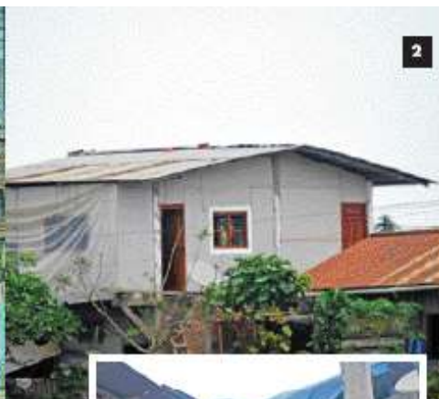
1. Barrio 25 de diciembre, calles sin pavimentar 2. Barrio 3 de noviembre, casas aún con plástico en las paredes
