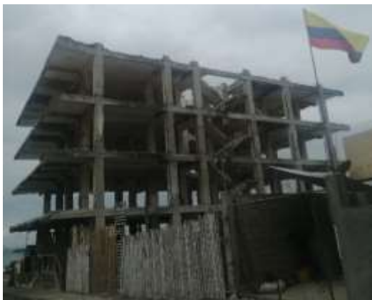
Malecón del Pedernales, estructura de edificio sin demoler
