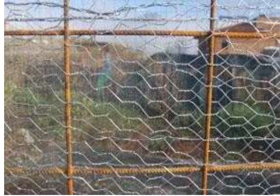
...a revisar los amarres de las dos capas de malla pollera con la electromalla...cuatro amarres cada cuadrado, de manera tal que se entrecrucen los hexágonos...
