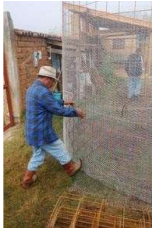
luego la malla del piso se corta en las orillas, y se dobla hacia la pared, a veces con la ayuda de una vareta
