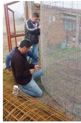
...se amarra cuidadosamente el piso con la pared al ser este un punto débil en la estructura de la cisterna, hay que hacer este trabajo cuidadosamente)
