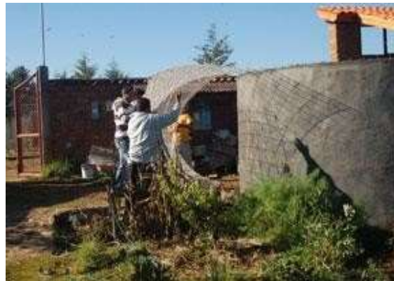
Ahora se coloca el techo, la estructura fue amarrada previamente de la misma manera como el piso y la pared
