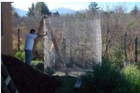
Se define la ubicación de la cisterna. Para el tanque grande de 30.000 ltrs se cava casi 50cm, para que quede por debajo de la canaleta de cosecha de aguas pluviales
