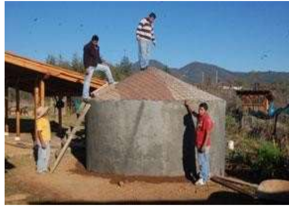
El equipo antes de colocar la primera mano al techo de la cisterna
