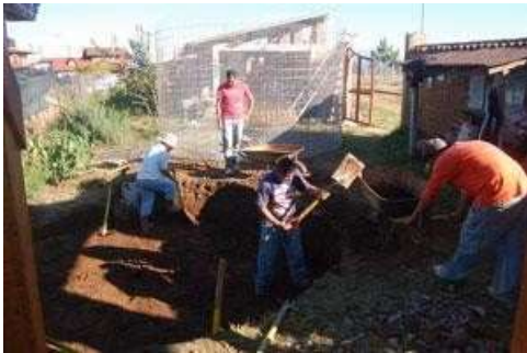
Se define la ubicación de la cisterna. Para el tanque grande de 30.000 ltrs se cava casi 50cm, para que quede por debajo de la canaleta de cosecha de aguas pluviales
