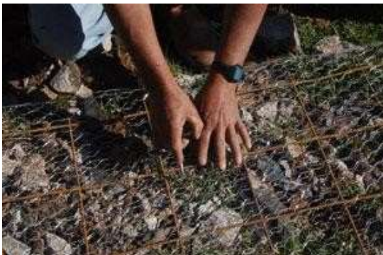
La parte artesanal del proceso: Entretejer las dos capas de malla pollera con la electromalla: Cuatro amarres en cada cuadrado de electromalla
