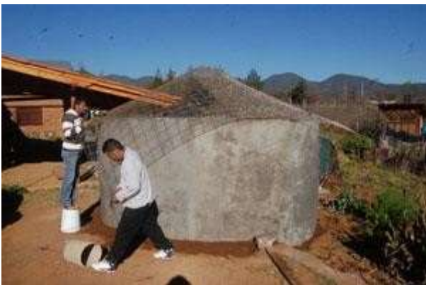
La colocamos de forma de "pirámide", para distribuir el peso hacia la pared de la cisterna.
