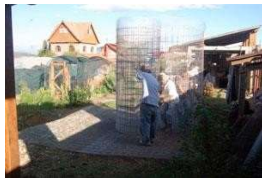
...y se le coloca por encima la malla tejida de la pared, de 12.90m de longitud (circunferencia más 30cm para el traslape)
