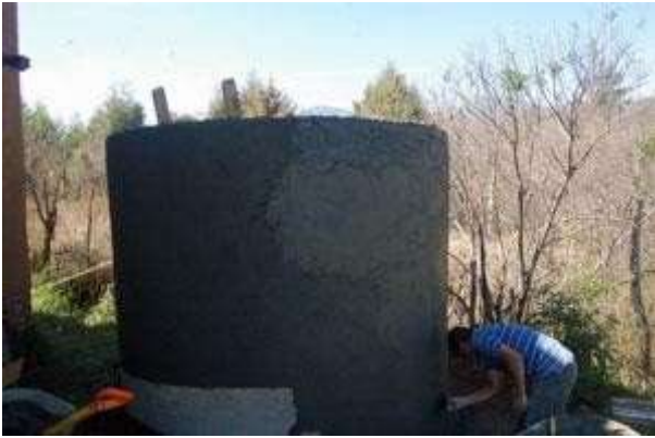
También por fuera se aplanan la cisterna con dos capas de cemento (el "aplanado" y el "fino")
