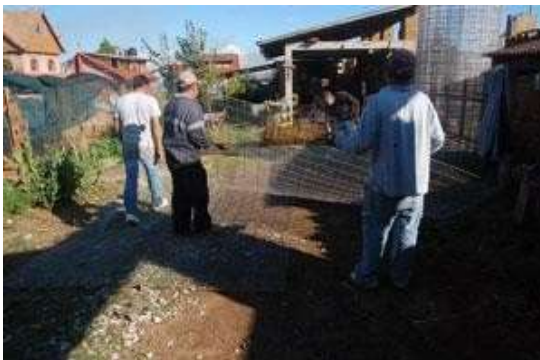
...lo mismo sucede con el piso de la cisterna... dos tramos de 4.50m de electromalla se entretejen con las dos capas de malla pollera. Luego estos se amarran...
