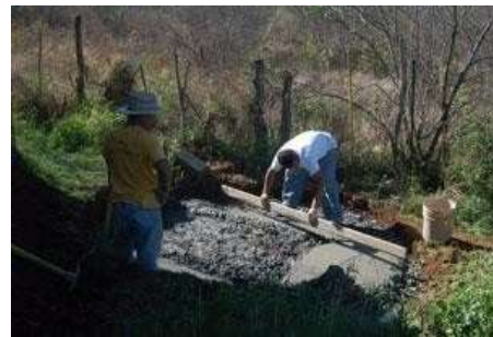
En terrenos firmes, basta con una capa de 8 cm de grava, y posteriormente tender un piso de concreto y grava (otros 8cm de grosor), para preparar el terreno
