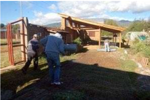
Posteriormente se vuelve a cubrir con la malla pollera (de preferencia del calibre 20/ 25)
