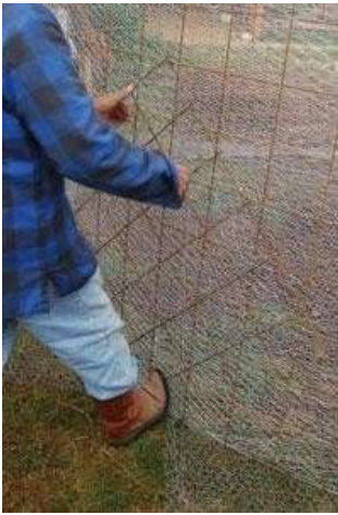
luego la malla del piso se corta en las orillas, y se dobla hacia la pared, a veces con la ayuda de una vareta
