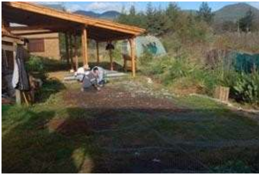
Preparando el enmallado: Primero se extienden y se juntan dos tramos de malla pollera, de preferencia del calibre 20/25
