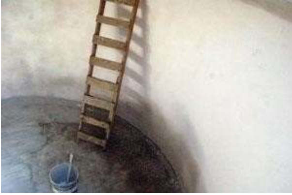
Con esto se pinta todo el interior de la cisterna...
