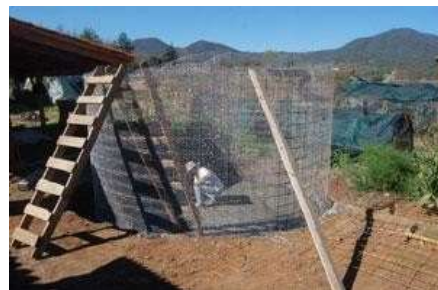
En terrenos firmes, basta con una capa de 8 cm de grava, y posteriormente tender un piso de concreto y grava (otros 8cm de grosor), para preparar el terreno
