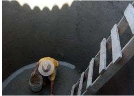
En el fondo por la orilla. Se coloca un "chafalán" de mezcla, para reforzar este punto donde la cisterna recibirá su mayor presión.
