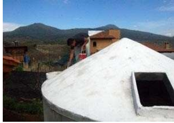
...y también el exterior (por lo menos la tapa, para reflejar un poco el calor del sol)
