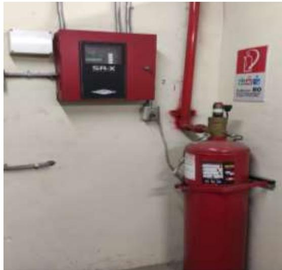
Figura. 39 Sistema contra incendio subestación Tecnova
