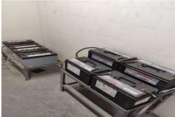
Figura. 37 Banco de baterías subestación Tecnova
