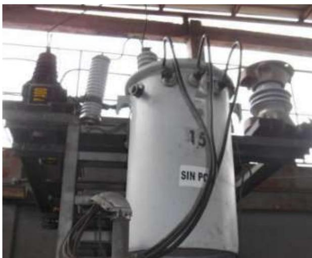
Figura. 12 Transformador de servicios auxiliares
