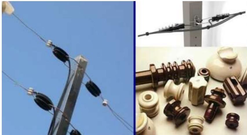
Figura. 29 Aislador de tracción
